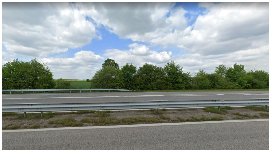
Vue au droit du site
