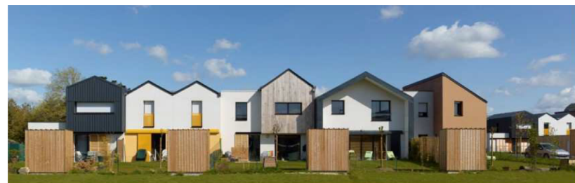
Opération groupée « Vert Buisson » à Bruz (35)
