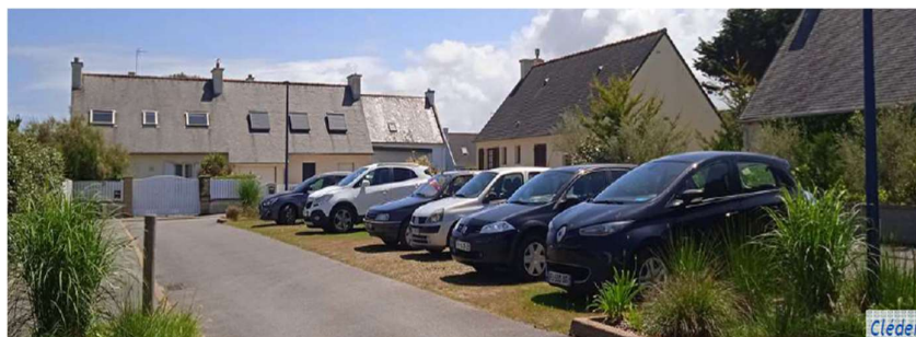
Le revêtement en dalles engazonnées est une solution durable par sa solidité et assure l'infiltration des eaux pluviales
