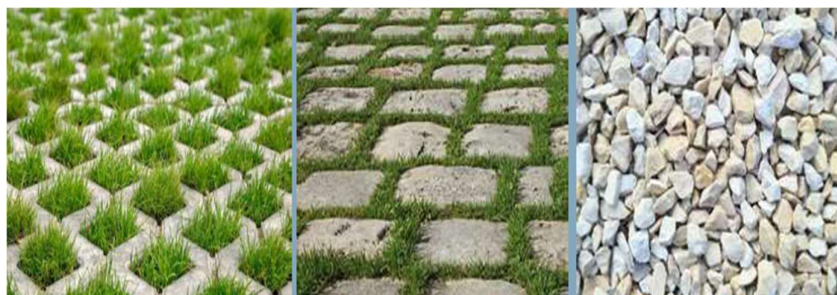
Revêtements poreux : dalles alvéolées, pavés engazonnés, gravillons
