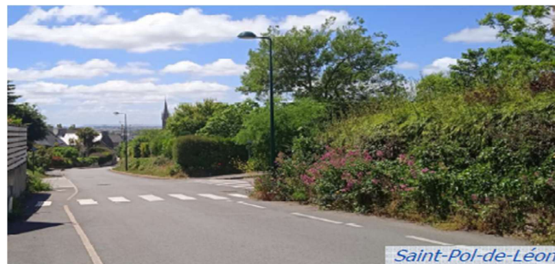
Rue de desserte : Ici la largeur de la voie est réduite, favorisant une circulation automobile plus lente. La liaison piétonne est sécurisée par un marquage au sol
