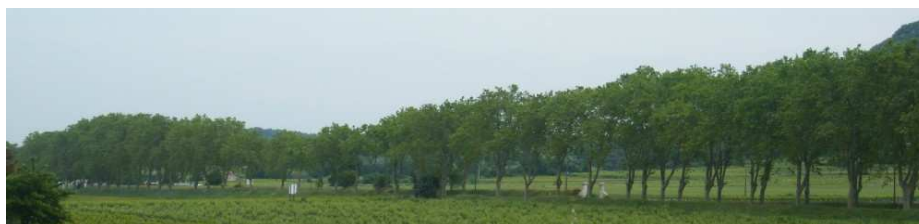
RD 6086 (ancienne N 86) bordée d'un alignement de platanes
