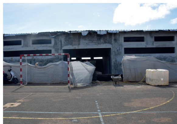
VESTIAIRE DU PLATEAU SPORTIF EN COURS DE RÉALISATION À CHICONI Cittànova 2019
