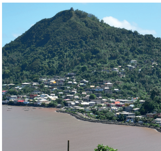
DES CONSTRUCTIONS QUI REGARDENT VERS LE LAGON À SADA Cittànova - 2019
