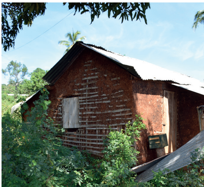
MAISON EN MATÉRIAUX VÉGÉTAUX À SADA Photo Cittanova - 2019
