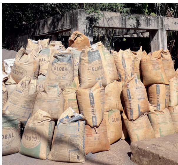
CIMENT IMPORTÉ POUR UNE CONSTRUCTION À M'TSANGAMOUJI Cittànova - 2019
