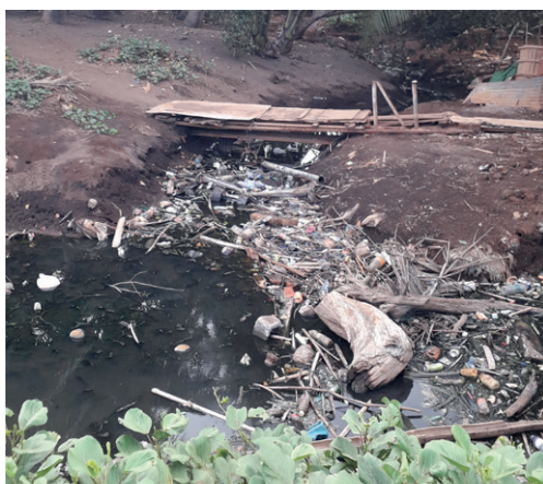
ACCUMULATION DE DÉCHETS DANS LES COURS D'EAU Cittànova - 2019
