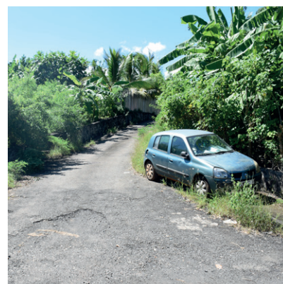
EXEMPLE DE STATIONNEMENT NON PRÉVU SUR LA VOIE PUBLIQUE Cittànova 2019
