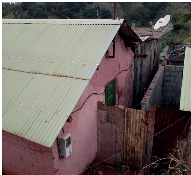
EXTENSION HORIZONTALE À TSINGONI Cittànova - 2019
