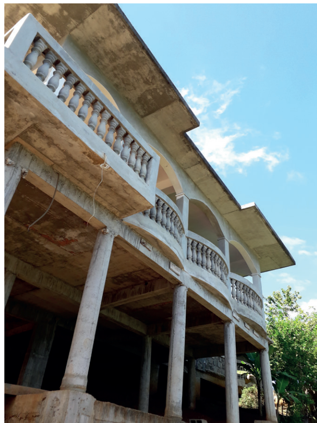
LOGEMENT EN COURS DE CONSTRUCTION POUVANT ÊTRE CONSIDÉRÉ VACANCE À SADA Cittànova - 2019
