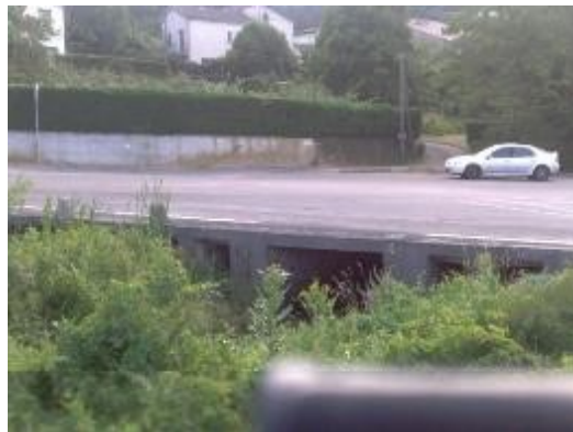
Ouvrage de la RD435 (MER03)
