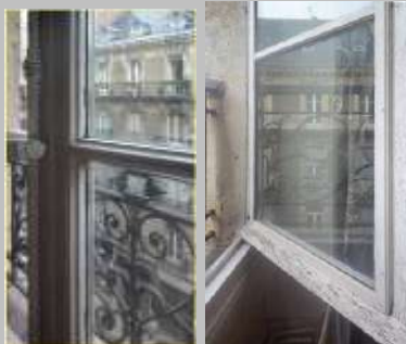
Doublage du vitrage
