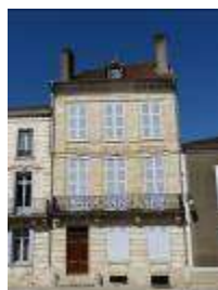
AY146 -18 rue du Gal Lamarque
