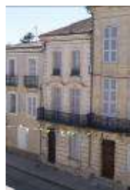
AY150 - 20 rue du Gal Lamarque
