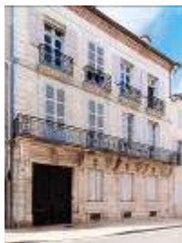
AY 140 - rue du Gal Lamarque
