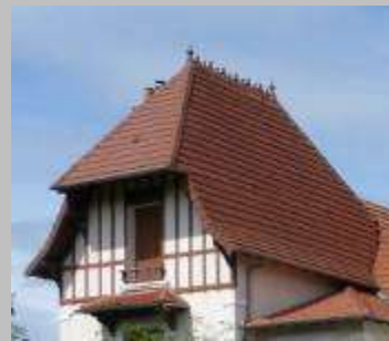
Couronnement de faîtage
