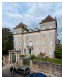
AY 27 - 11 rue du Gal Lamarque
