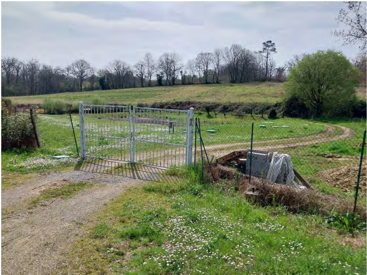
Figure 18 : Vues d'ensemble de la station d'épuration
