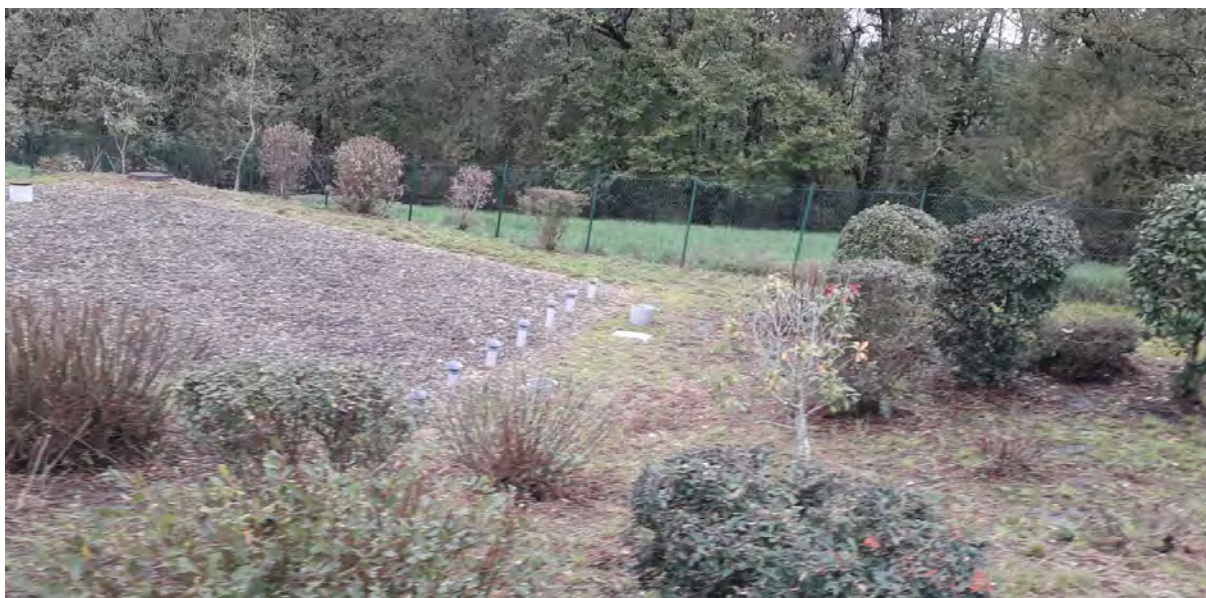
Figure 17 : Vue d'ensemble de la station d'épuration de Morganx
