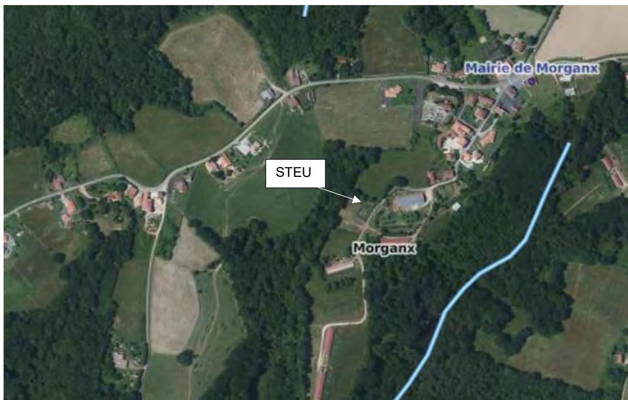
Figure 16 : Vue aérienne de la station d'épuration
