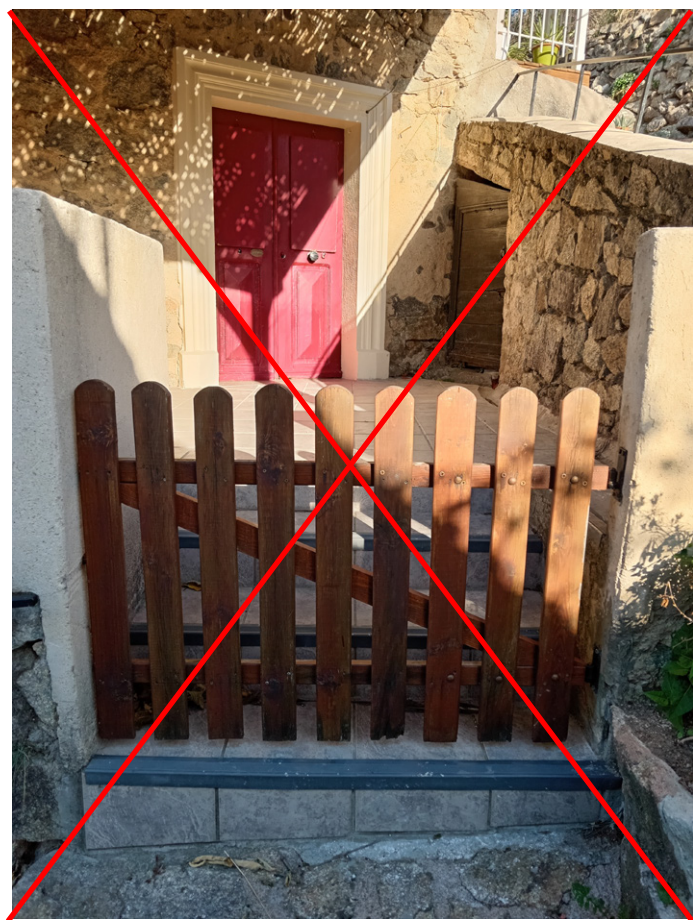
Terrasse carrelée avec nez de marche en métal en contradiction avec le caractère historique des matériaux mis en oeuvre pour la construction.
