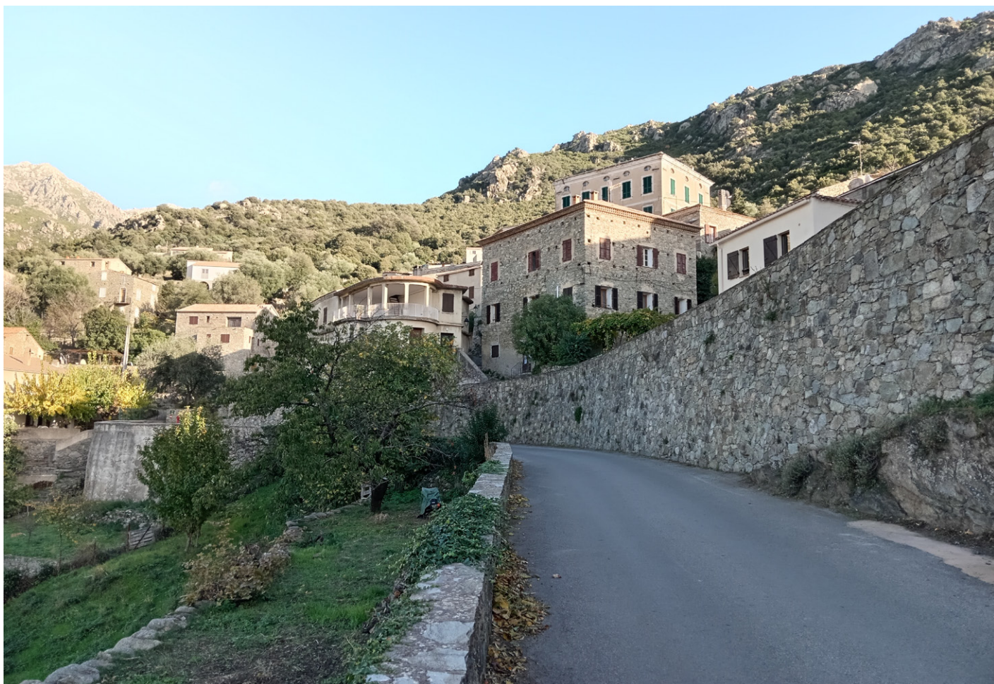
Exemple de terrassements «historiques» : à gauche, les jardins en terrasses du vallon, à droite, le route de Tricellu. Dans le premier cas, les murs de terrassement sont en pierres sèches et assurent un drainage sur l'ensemble de sa surface, tandis que dans l'autre cas, la réalisation de barbacanes garantit l'évacuation des eaux contenues dans les terres.
