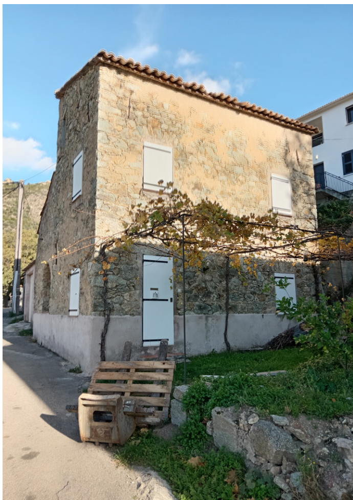
Exemple de tonnelle légère dans le secteur historique, en rez-de-chaussée (quartier d'U Pughjola) : les lignes sont sobres et des pieds de vigne ont investi la ferronnerie de couleur noire.
