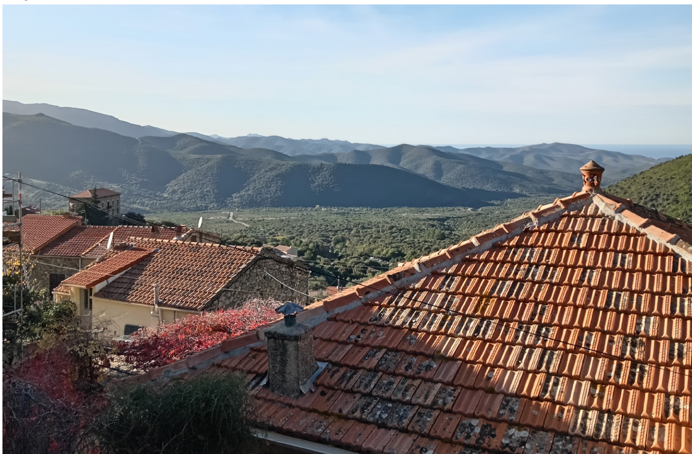
Les situations fréquentes de surplomb sur les constructions du village, depuis l'espace public, implique l'importance de soigner la forme des toitures et la qualité des couvertures.
