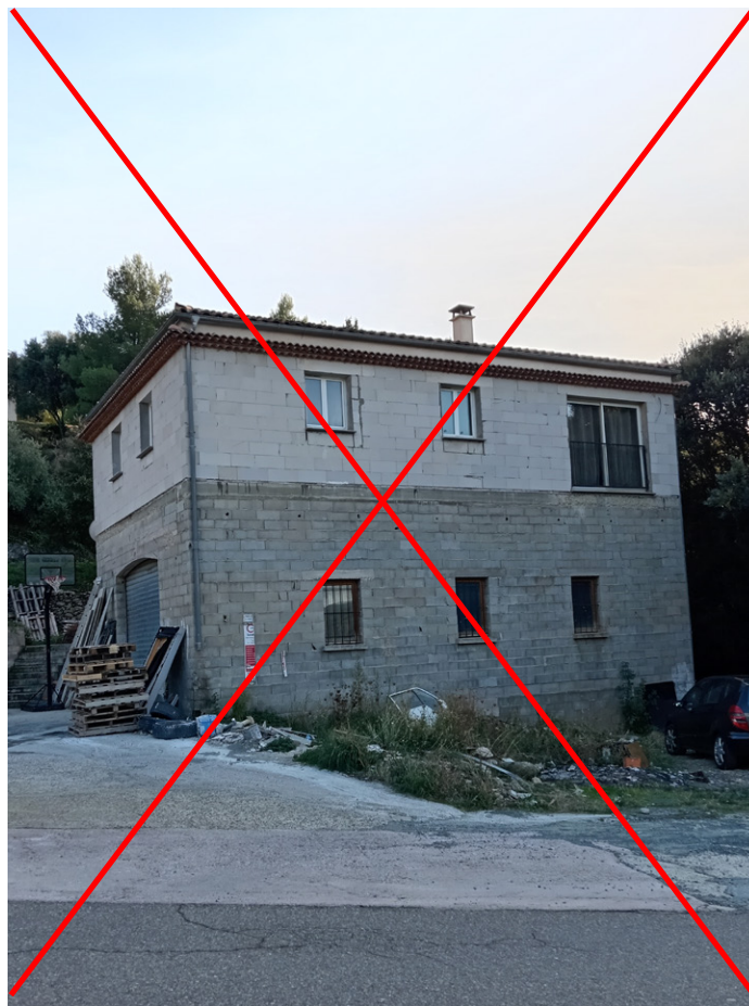
Construction présentant une façade non enduite et une ouverture carrée en R+1.
