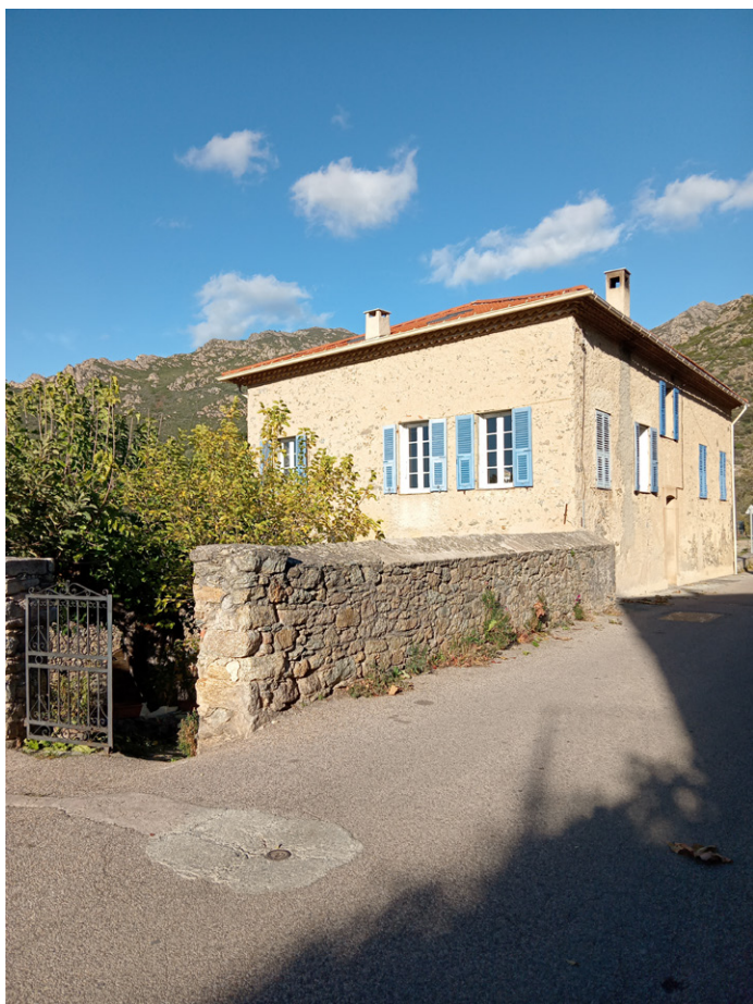
Dans le quartier d'U Pughjola : mur de clôture maçonné en pierres apparentes comprenant un couronnement avec plan-incliné sur l'espace public et accompagné d'un portail en fer-forgé de couleur noire.
