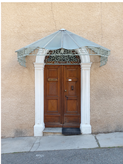
Exemple de marquise dans le centre ancien d'Urtaca
