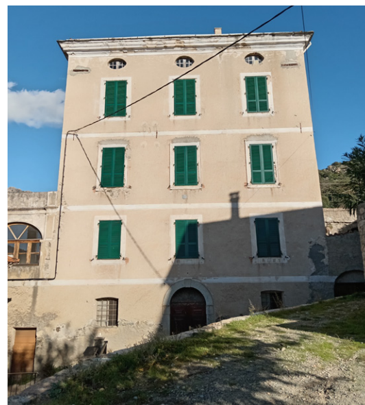
Exemple de maison de maître mitoyenne avec hauteur remarquable en milieu historique de Tricellu avec trois travées de fenêtres sur 4 niveaux plus combles et toiture quatre pentes.
