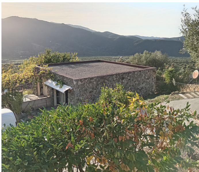
Quartier de San Niculau : toiture en terrasse non accessible sur un volume en RDC
