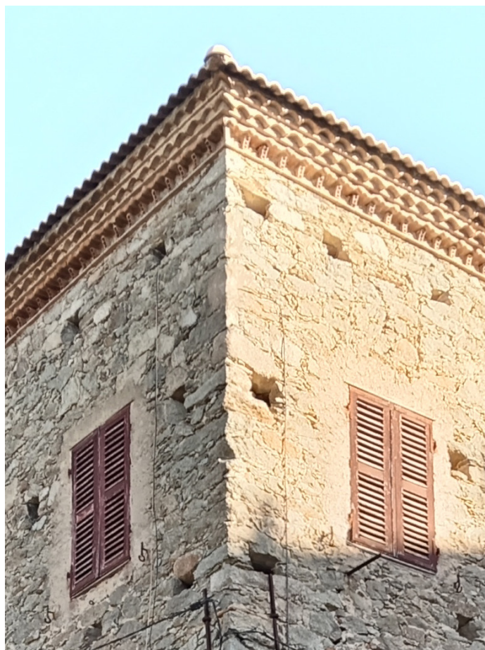
Détail de corniche avec des rangs de génoises en tuiles rondes.
