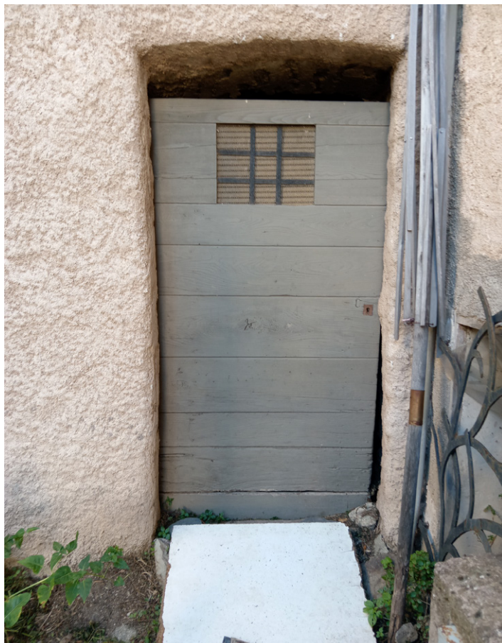
Porte d'entrée à simple vantail, avec lames pleines horizontales avec fenêtre de ventilation (la porte dominant probablement sur une cave)
