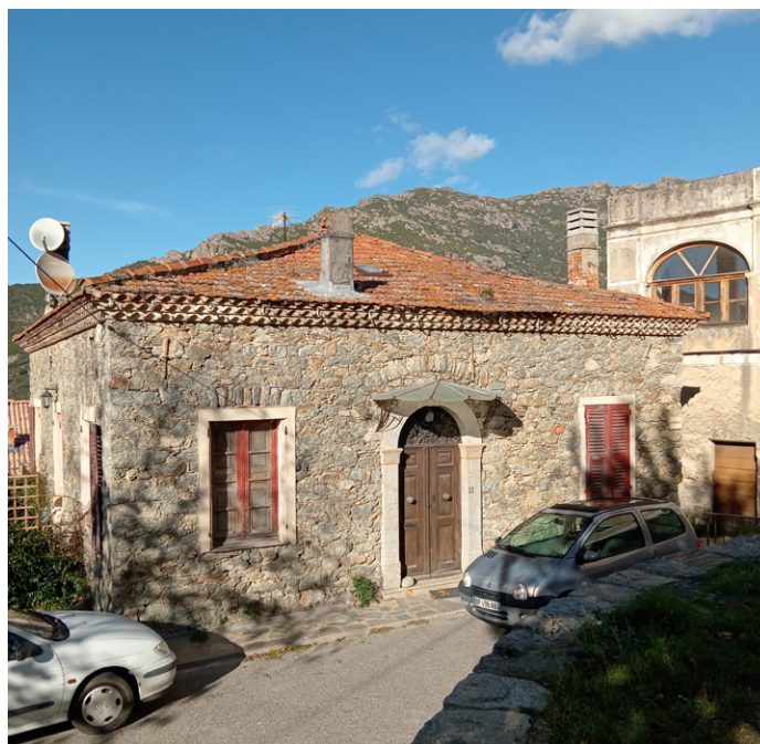
Quartier de Tricellu : rare cas de toiture à quatre pente sur un volume bâti en RDC. La toiture à quatre versants est généralement employée pour les volumes bâtis de type maison de maître.
