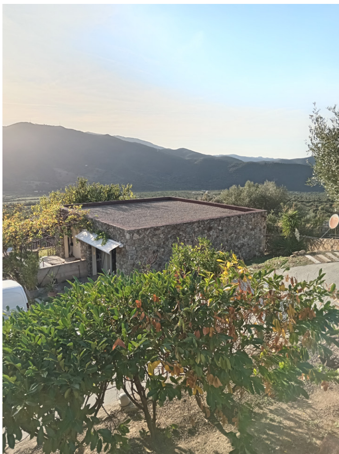
Toiture en terrasse inaccessible couverte d'un concassé de pierre dont la teinte respecte le contexte environnant (paysage et construction). Bien qu'ils soient peu traditionnels, les relevés d'étanchéité sur les acrotères ont été plutôt bien intégrés grâce au choix judicieux de la couleur.
