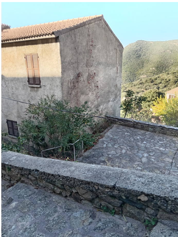
Terrasse en dalles de pierres (type Brando peu adéquate en milieu Balanin mais ayant le bénéfice de présenter un matériaux noble et pérenne), posées en opus incertum. Le jointement grossier en ciment est néanmoins maladroit : un jointement avec de plus petites pierres aurait été plus élégant.
