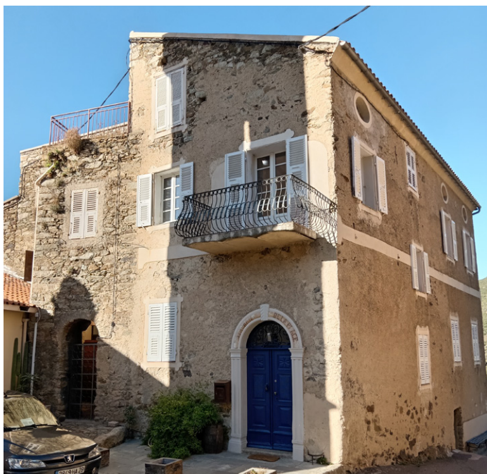
Quartier de Tricellu : les toitures s'orientent en fonction de l'importance de la voirie. Dans le centre ancien, les versants sont majoritairement à une ou deux pentes avec, ponctuellement, l'existence de toiture en terrasse souvent accessibles.
