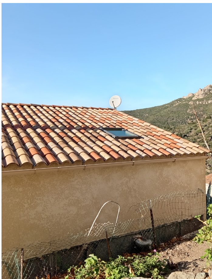
Toiture couverte de tuiles canal présentant une diversité de couleurs dans la palette des ocres-rouges et orangés.
