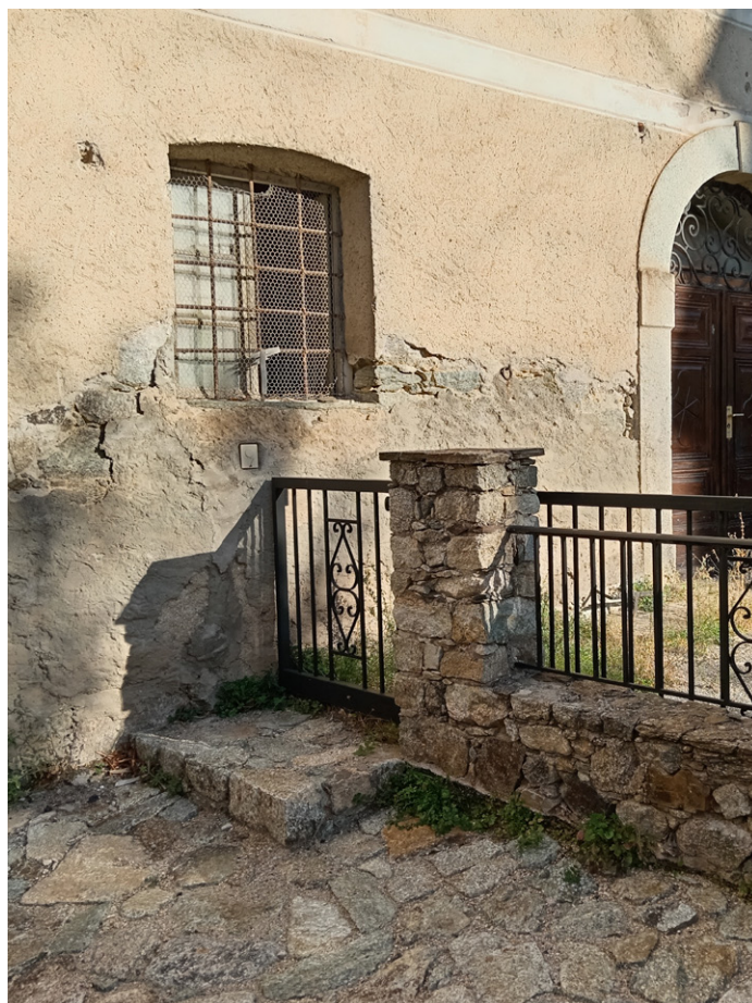
Dans le quartier de Tricellu : mur-bahut maçonné en pierres apparentes, surmonté d'une grille en fer-forgé de couleur noire. L'ensemble présente une hauteur de 1,20m environ.
