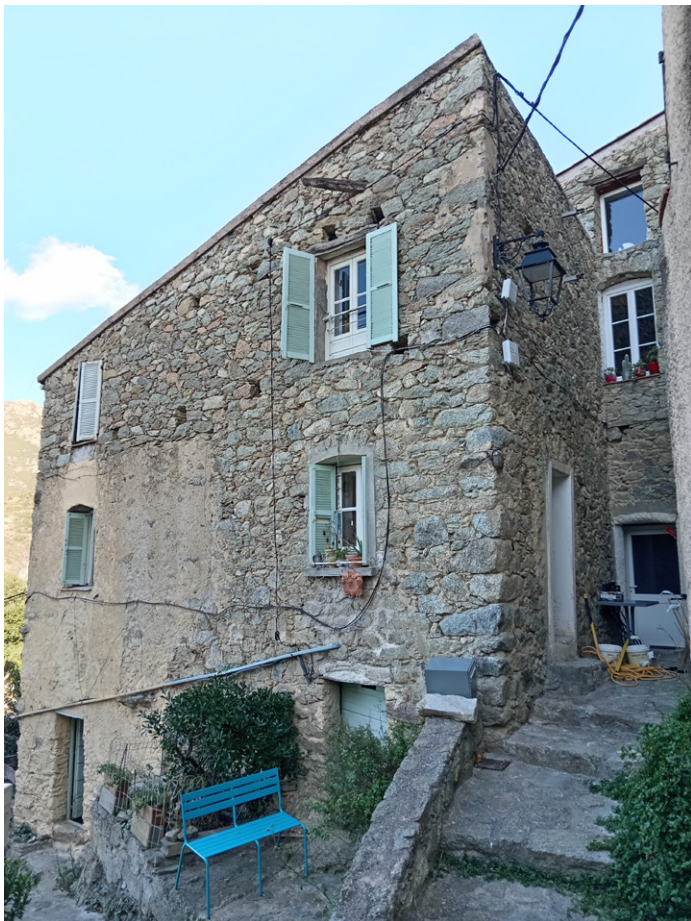
Façade pignon ouverte d'une double travée de baies dans le quartier de Tricellu. Présence de trous de boulins en façade à préserver.
