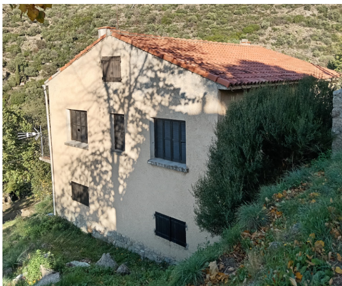
Quartier de Pughjola : toiture à deux versants symétriques.
