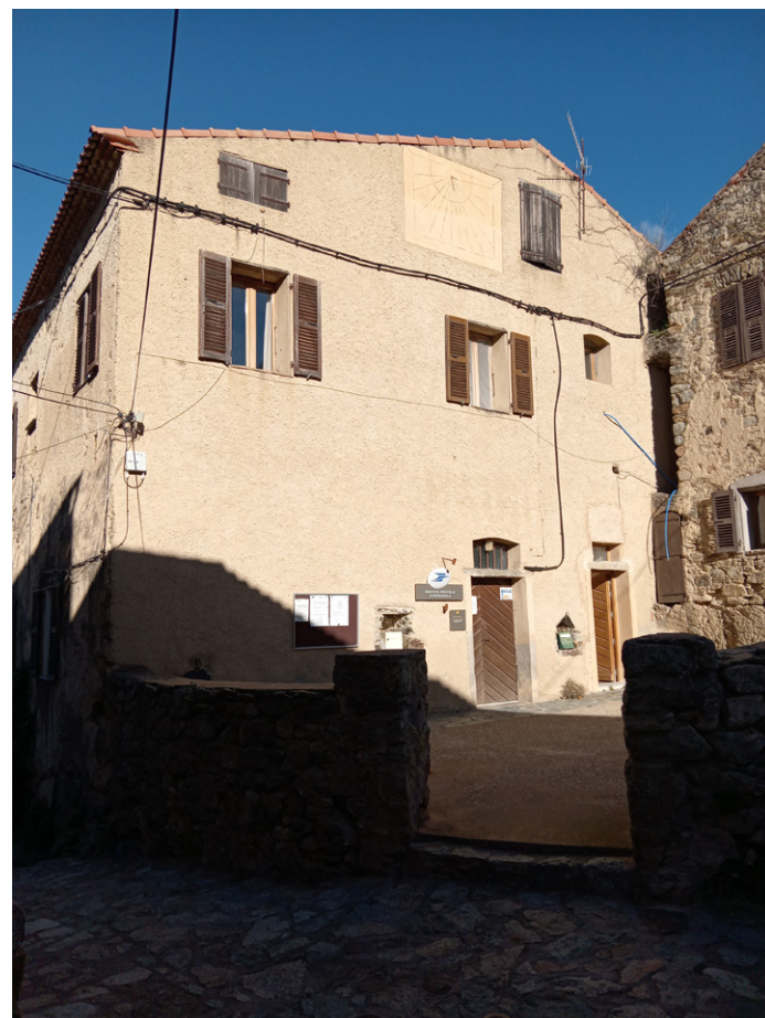
Terrasse de la Mairie réalisée en béton désactivé avec pied de mur en dalles de pierres posées en opus incertum : l'emploi de matériaux mixte peut être une réponse idéale pour assurer une intégration patrimoniale et équilibrer le budget.
