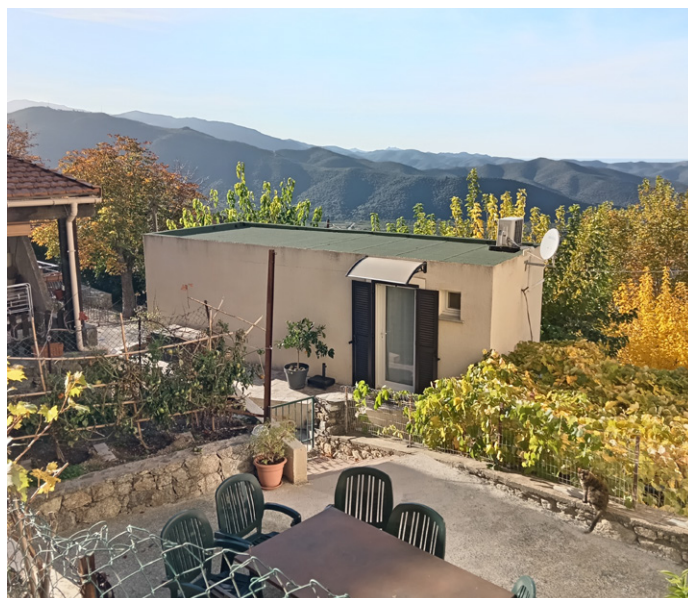
Quartier de Pughjola : toiture en terrasse non accessible sur un volume en RDC
