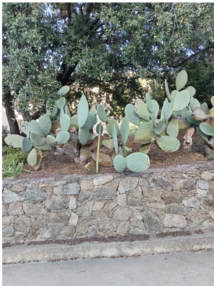
Dans le quartier de Chjosu a a Leccia : mur de clôture (formant soutènement) maçonné en pierres apparentes surmonté d'une haie de figuier de Barbarie (fonction antri-intrusion) et de chênes verts.
