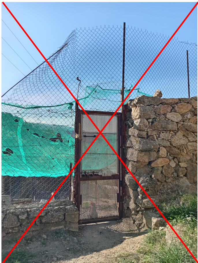
Exemple à ne pas suivre : clôture trop haute réalisée avec des matériaux hétéroclites et présentant une absence totale d'entretien. L'ensemble des parties en grillage fin et en matériaux plastique est à déposer : privilégier l'emploi de grilles de couleur noire à coordonner avec le portail en fer.
