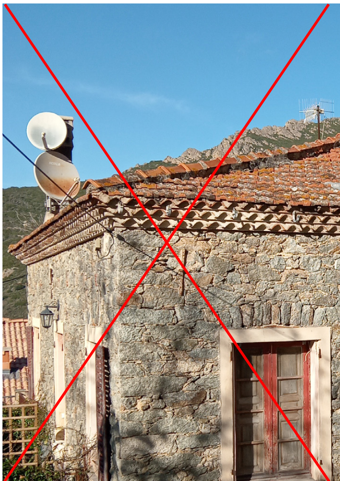
Les paraboles et antennes peuvent être aménagées dans les combles.
