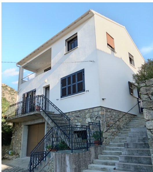
Exemple de pavillon réalisé entre 1950 et 1980 dans le quartier d'U Pughjola : les volumes sont plus imposants mais les dispositions architecturales reprennent le caractère élancé des façades historiques et les toitures sont souvent à deux pentes.
