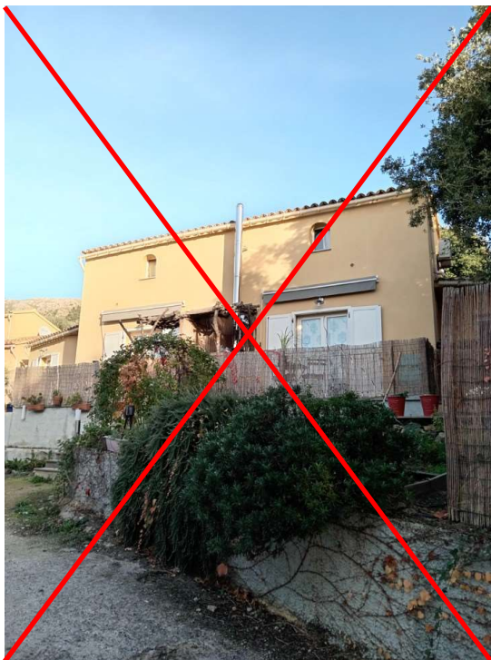
Les stores électriques ne sont pas adaptés.
