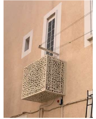
Exemple de coffrage sous une fenêtre donnant l'impression d'un petit balcon.
