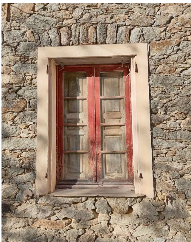
Fenêtre en bois à deux vantaux recoupée de 8 carreaux de vitrage. Présence de volets intérieurs
