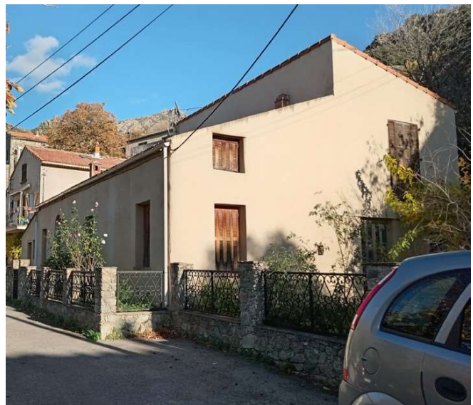
Quartier de Pughjola : toiture à deux versants asymétriques.
