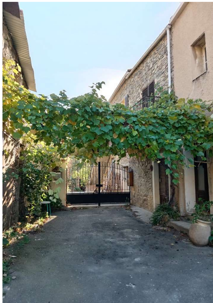
Autre exemple marquant une séquence d'entrée, entre deux îlots bâtis, en rez-de-chaussée.
