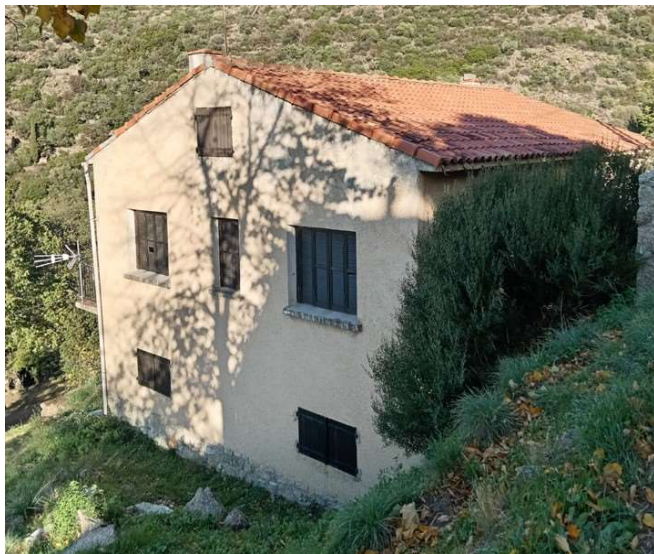
Quartier de Pughjola : toiture à deux versants symétriques.
