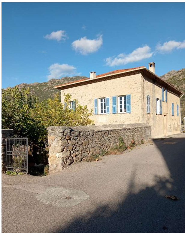
Dans le quartier d'U Pughjola : mur de clôture maçonné en pierres apparentes comprenant un couronnement avec plan-incliné sur l'espace public et accompagné d'un portail en fer-forgé de couleur noire.
