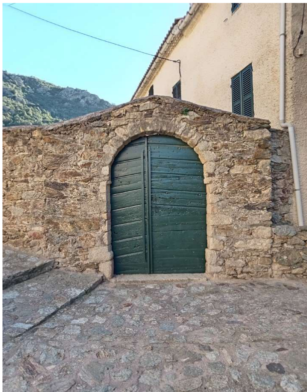
Dans le quartier de Tricellu : clôture maçonnée en pierres apparentes d'une hauteur d'environ 2 mètres, surmontant ponctuellement un portail en bois à lames pleines et double recouvrement peint en vert sapin.
