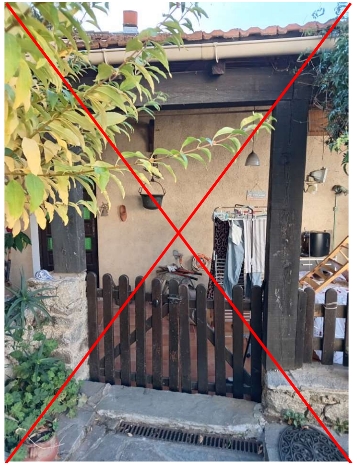
Au coeur du village ce auvent alourdit visuellement la silhouette de la construction : une structure plus légère aurait été mieux intégrée au contexte historique.
