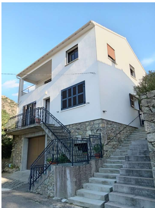
Construction ouverte sur l'ensemble de ses façades. Présence d'escaliers extérieurs parallèles à la façade et d'une loggia en R+2.
