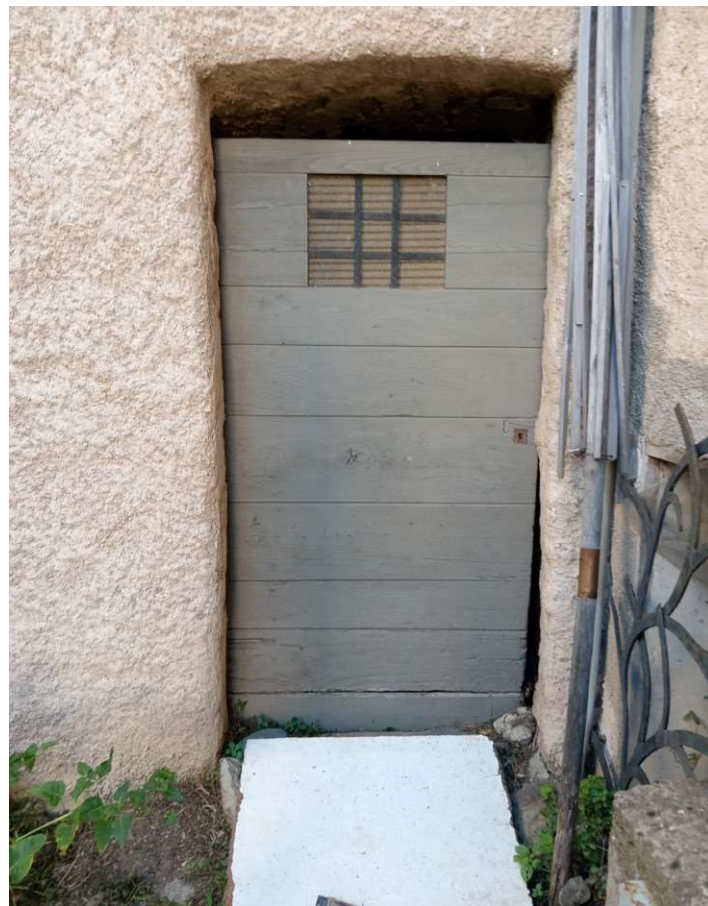
Porte d'entrée à simple vantail, avec lames pleines horizontales avec fenêtre de ventilation (la porte donnant probablement sur une cave)
