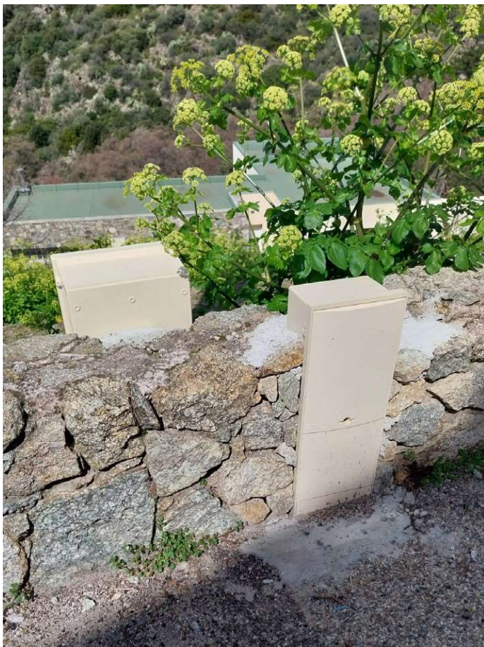
Les compteurs se présentent en saillie vis à vis du couronnement du mur et leur couleur trop claire nuisent visuellement au contexte patrimonial.
