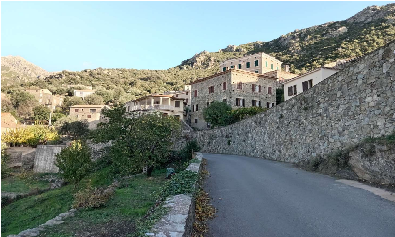
Exemple de terrassements «historiques» : à gauche, les jardins en terrasses du vallon, à droite, la route de Tricellu. Dans le premier cas, les murs de terrassement sont en pierres sèches et assurent un drainage sur l'ensemble de leur surface, tandis que dans l'autre cas, la réalisation de barbicanes garantit l'évacuation des eaux contenues dans les terres.
