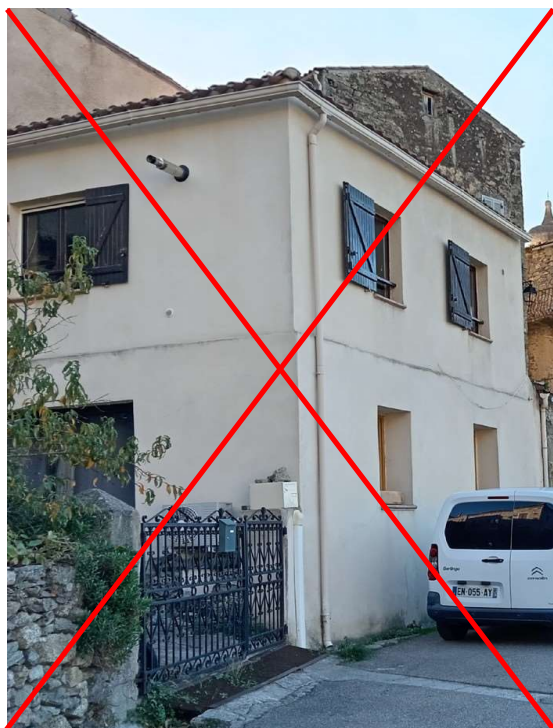
Les conduits de poêle à bois doivent être discrets : les matériaux trop brillants sont souvent impactants dans un contexte historique. Les conduits de poêle ou de cheminée installés en saillie sont à proscrire.
