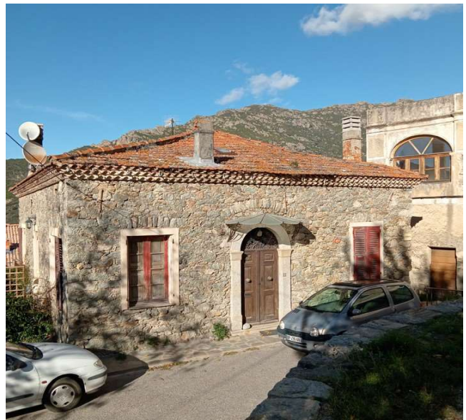
Quartier de Tricellu : rare cas de toiture à quatre pente sur un volume bâti en RDC. La toiture à quatre versants est généralement employée pour les volumes bâtis de type maison de maître.
