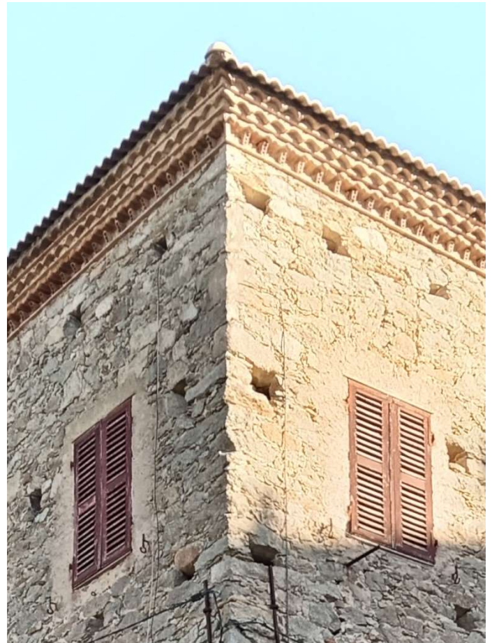
Détail de corniche avec des rangs de génoises en tuiles rondes.
