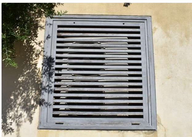
Exemple d'un volet en bois à persiennes mis en oeuvre pour l'occultation d'un équipement encastré en façade (exemple à Lumio)
