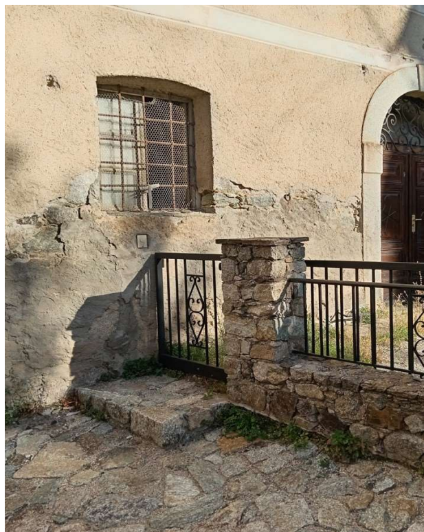
Dans le quartier de Tricellu : mur-bahut maçonné en pierres apparentes, surmonté d'une grille en fer-forgé de couleur noire. L'ensemble présente une hauteur de 1,20m environ.
