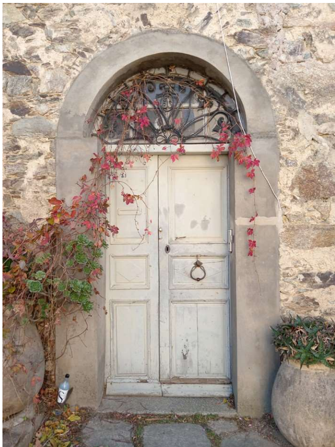
Porte d'entrée à deux vantaux, comprenant des panneaux menuisés et une imposte vitrée accompagnée d'une ferronnerie à volutes
