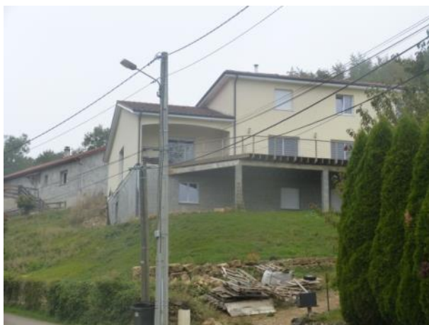
Construction récente en bordure de la rue des Ermites
