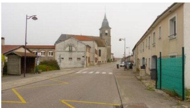
Traversée au niveau de la centralité
