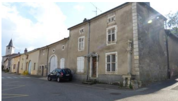
Organisation du bâti le long de l'axe principal : alignement
