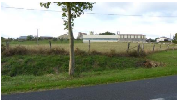
L'ancienne menuiserie au Sud du village
