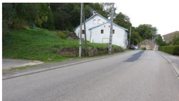
Discontinuité naturelle du bâti Grande Rue
