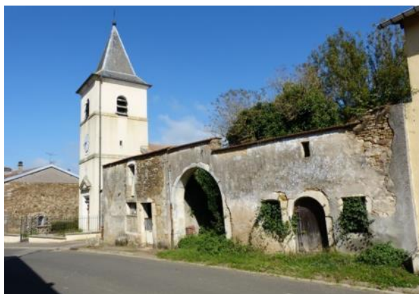
Bâtiment à acquérir par la commune et à détruire
