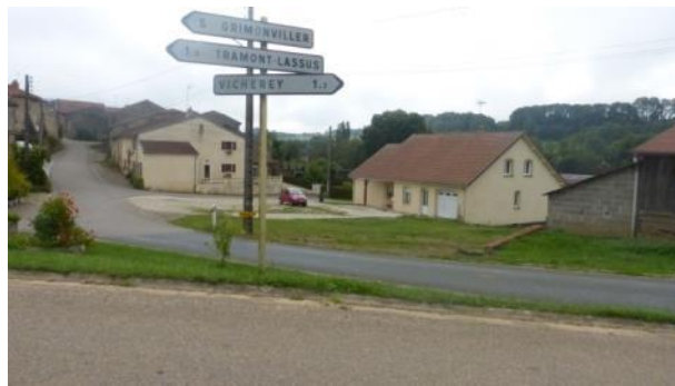
Nouvelle construction « isolée » en entrée Ouest par la route de Vicherey (rue Charentoise)
