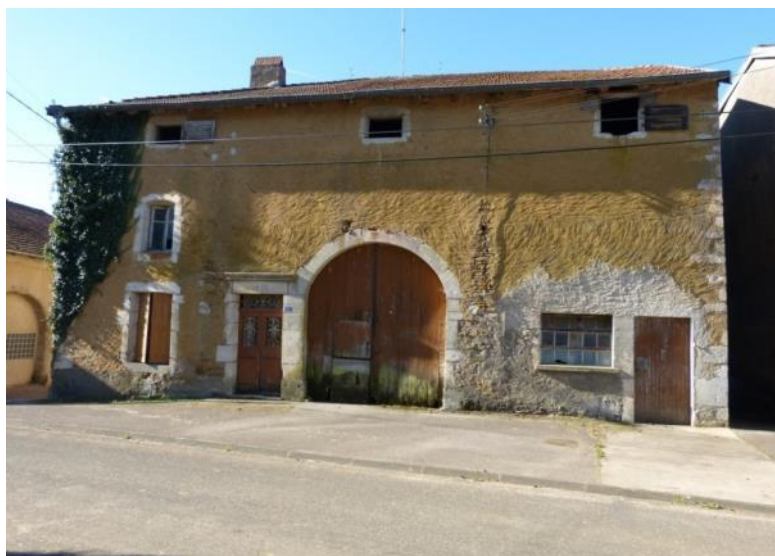
Ferme à 3 travées à Tramont-Emy
