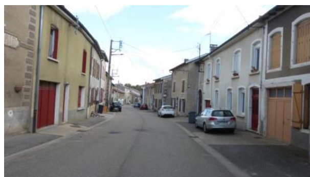
Structure bâtie du centre ancien : rue Emile Bernheim
