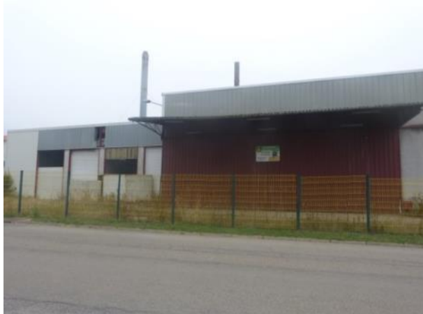
Friche en bordure de la RD 12
