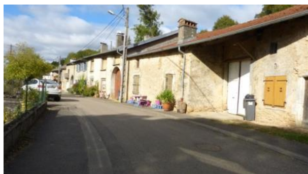
Structure urbaine avec mitoyenneté forte : rue du Moulin
