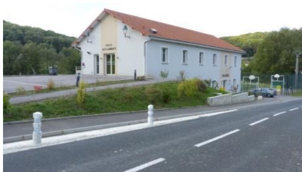
Espace public assurant la continuité urbaine rue de la Tournelle
