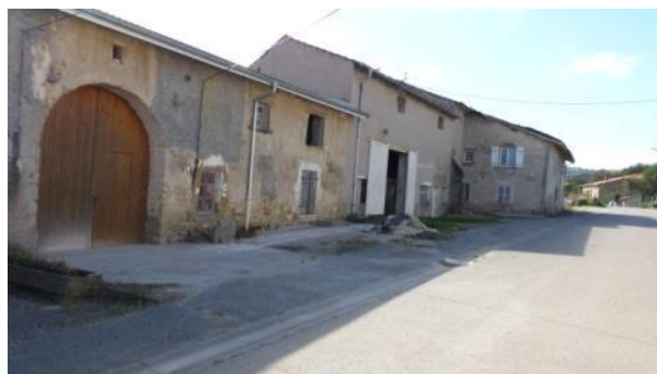
Bâti traditionnel rue Saint-Léon
