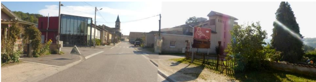
Structure urbaine de la RD4, au droit de la plateforme verrière
