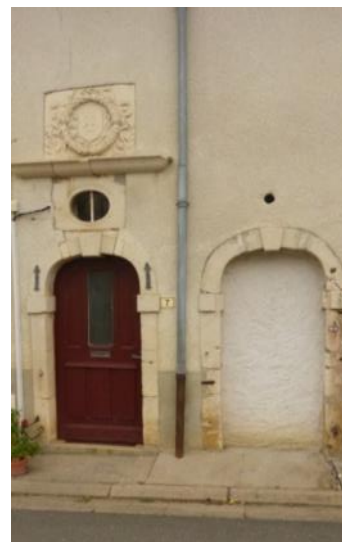
Détails architecturaux remarquables
