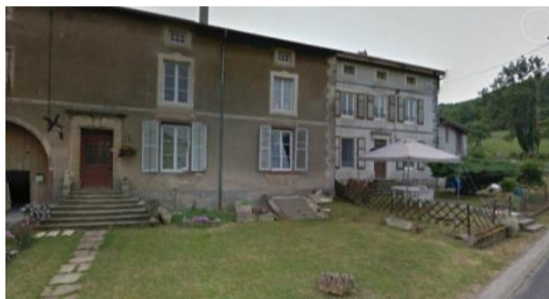
Spécificités architecturales / bâti rue de l'Aire : perron ; parements d'angle
