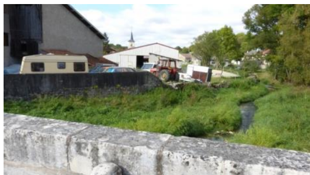
Bâti agricole en bordure de l'Aroffe
