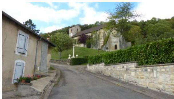
Rue de l'Église : site remarquable
