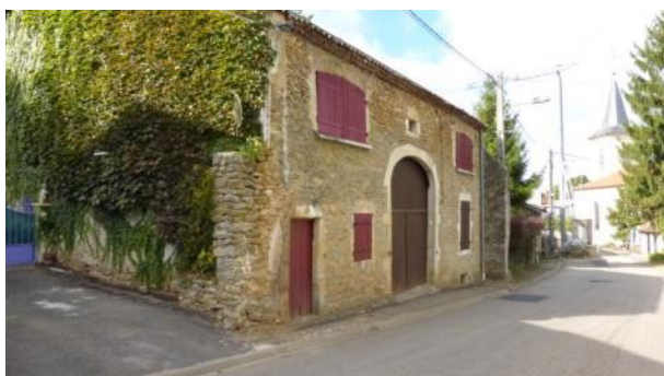
Discontinuité artificielle du bâti Grande Rue
