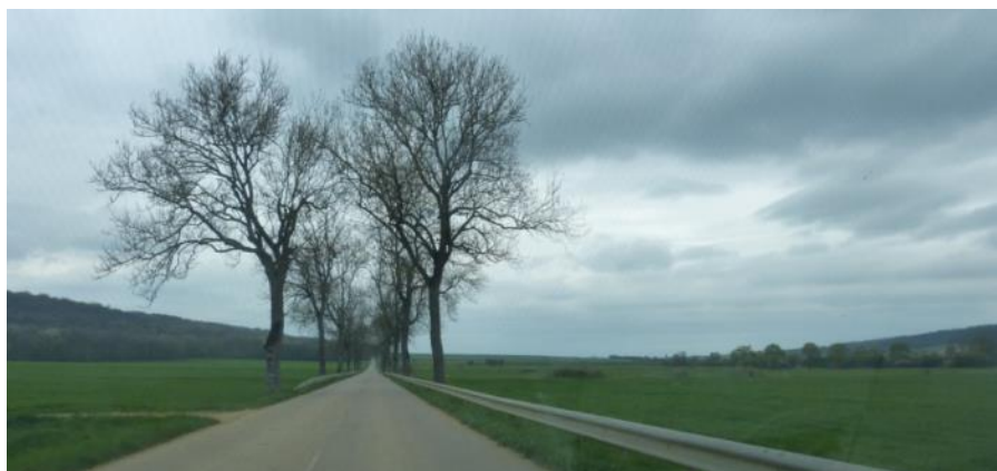
Entrée Ouest au niveau de Gibeauveix – RD 4
