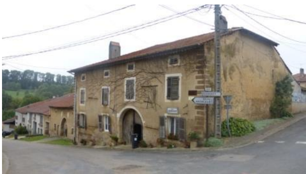
Structure du bâti rue de l'Étroit
