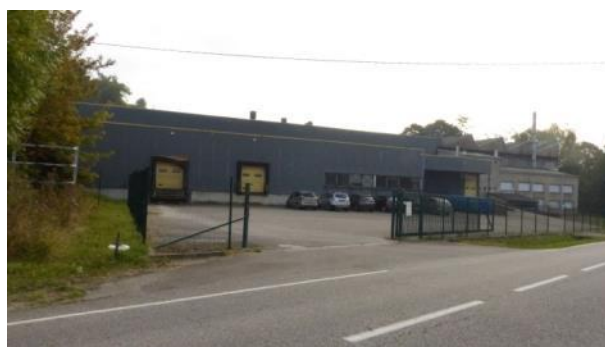
Daum : bâtiments industriels récents
