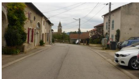
Structure urbaine de la RD904 (rue de l'Eglise).
