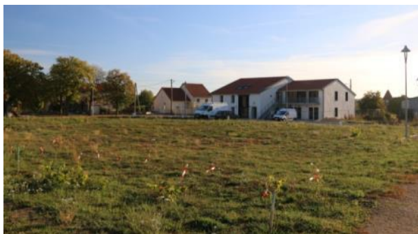
Lotissement pavillonnaire en cours
