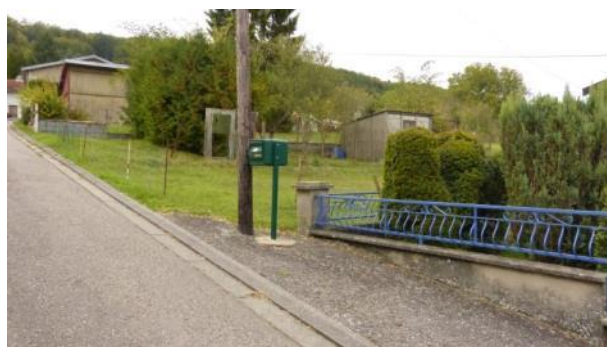
Imbrication des espaces construits / espaces non construits : rue du Moulin
