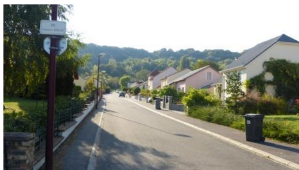
Extension urbaine perpendiculaire à l'axe principal (RD11) : rue E. Didelot
