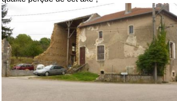
Bâti dégradé le long de la RD904.
