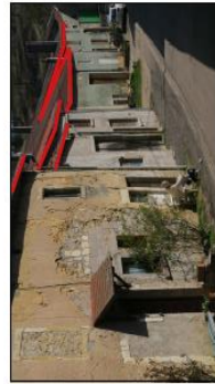
Décrochés de toitures fréquents (topographie) - Front à tendance homogène
