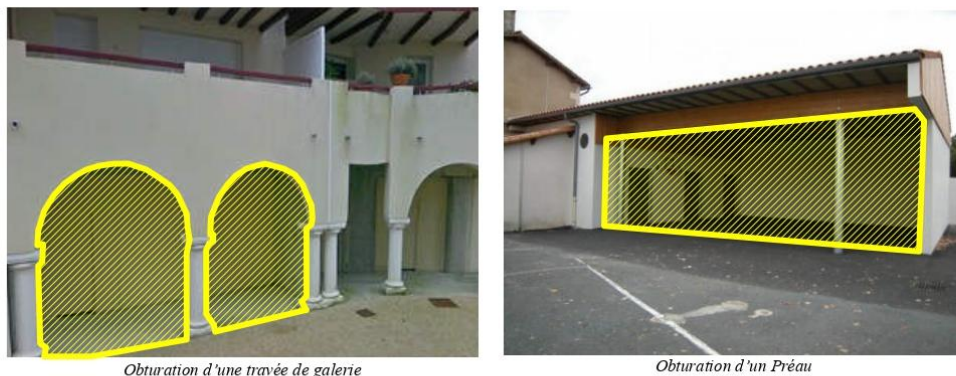
Obturation d'une travée de galerie
