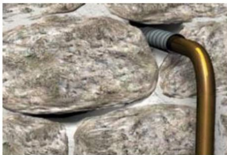
Situation initiale avant colmatage
