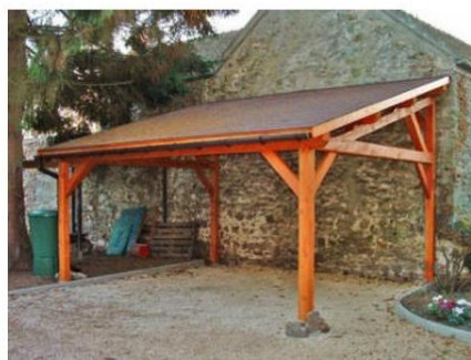
Abri de protection accolé à bâtiment (adjonction)
