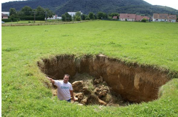
Effondrement dans un pré à Santoche (25) en été 2012 Source : www.estrepublikain.fr
