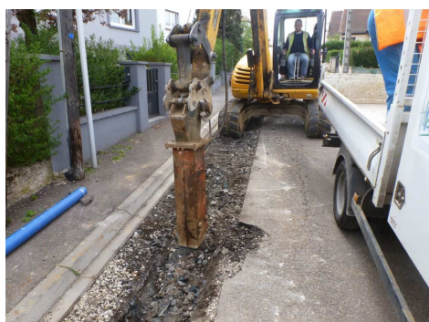
Travaux de renouvellement - conduite DN 100 Rue Brondex à METZ
