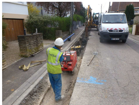
Travaux de renouvellement - conduite DN 100 Rue Brondex à METZ
