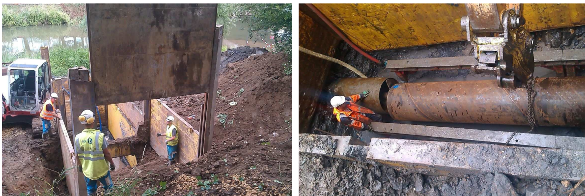
Travaux de mise en place de blindage au niveau des fosses pour le fonçage au niveau de la Seille à METZ
