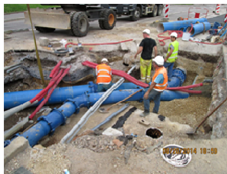
Travaux de renouvellement - conduite DN 300 et DN 450 rue Paixhans à Metz
