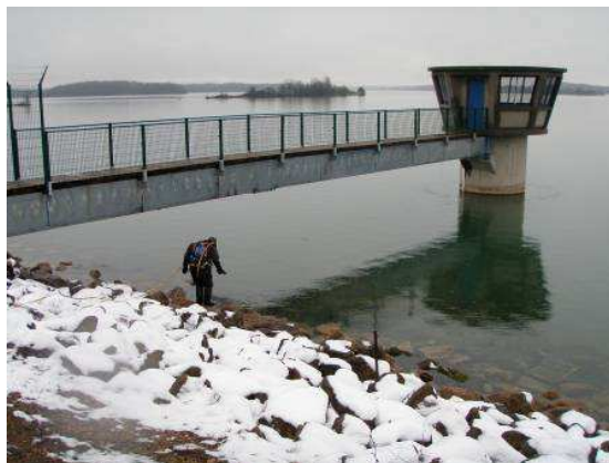
Prise d'eau au niveau de la digue de Marmont (Madine)
