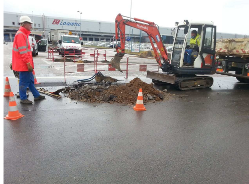
Travaux de renouvellement - organes et branchements sur le réseau de Metz
