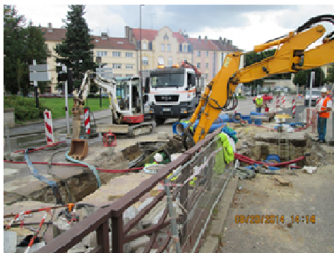
Travaux de renouvellement - conduite DN 300 et DN 450 rue Paixhans à Metz
