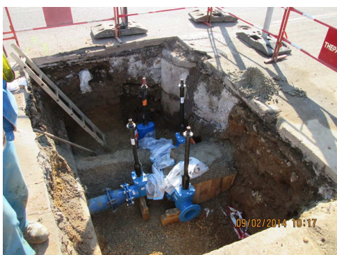
Travaux de renouvellement - organes et branchements sur le réseau de Metz
