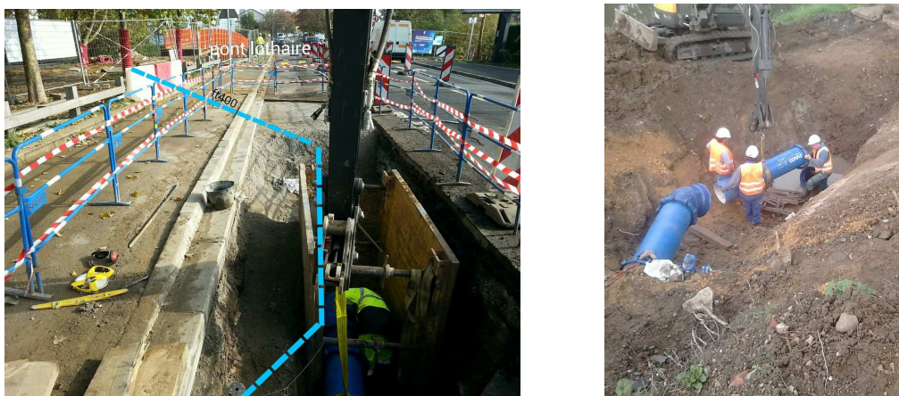
Travaux de pose de canalisation DN 400 rue Lothaire et coté Piscine à METZ
