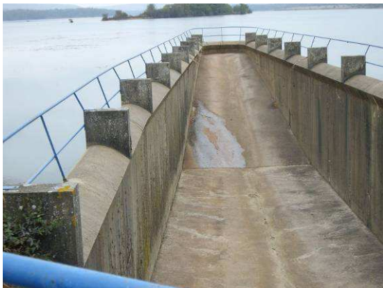
Évacuateur de crues
