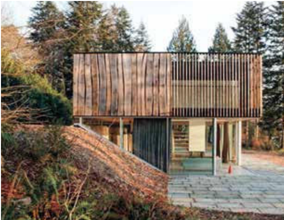
Lode Architecture - Maison D - 2012 Bretagne © Daniel Moulinet
