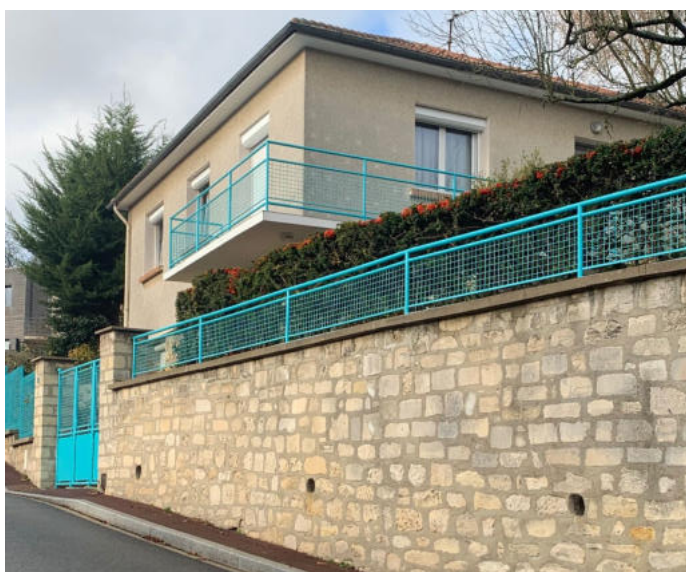
2, rue des Jonquilles Travail colorimétrique sur la clôture et le garde-corps
