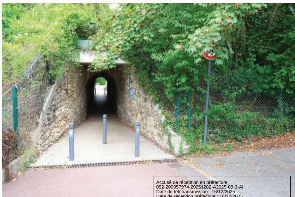
Passage piétons sous voie SNCF depuis la rue Jean Jaurès vers la rue Léon Gambetta
