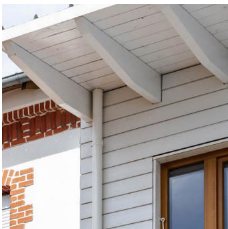
Mir architecte Bagnolet, 2019 © Tilt & Shoot Bardage de bois blanc horizontal
