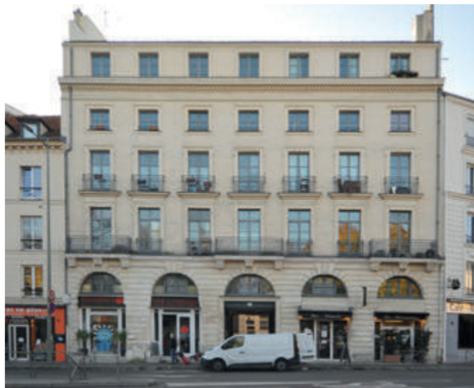
3 Grande Rue : Arcades composant la façade
