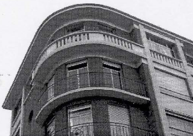
Huisseries bois. Immeuble de rapport, 3, 3bis, 3ter av. J. B. Clément, 1934, M. Julien & L. Duhaion architectes.
