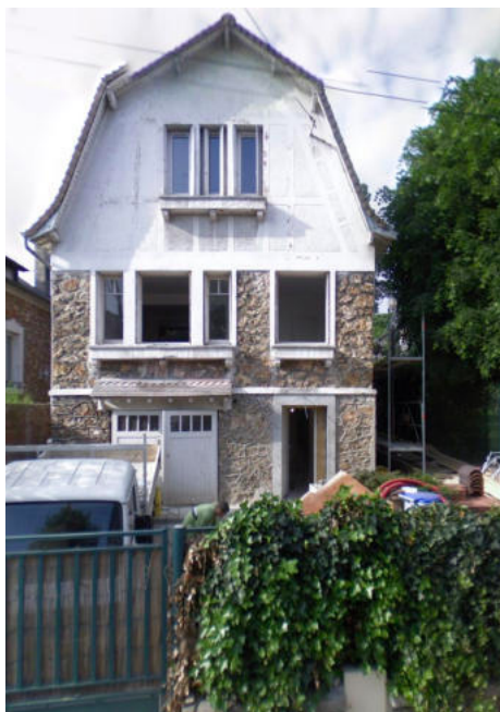
Façade rue existante
