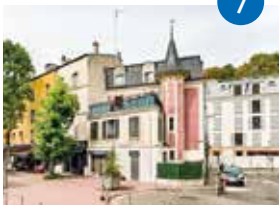
Le centre ancien
