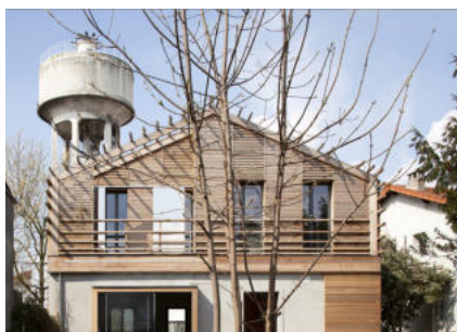
Djuric, Tardio, architectes.
