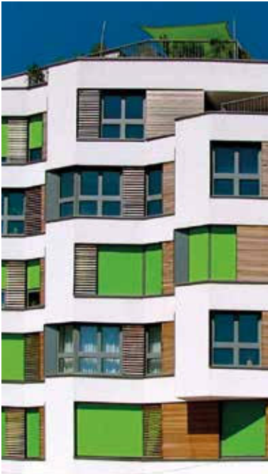
Les décrochés dynamisent la façade sur rue et permettent d'amortir le bruit ambiant désagréable provenant de la rue et des automobiles (bâtiment passif).
