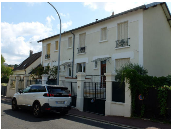
8/10 et 12 avenue Fourchon
