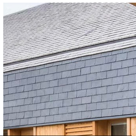
Accusé de réception en préfecture 0921200379/4-2025-09-4-AI Date de télétransmission : 16/12/2025 Date de réception en préfecture : 16/12/2025 © Sergio Grazia Ardoise naturelle avec dispositif eaux pluviales intégré
