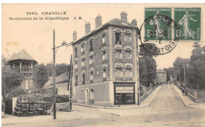
Hier, une graineterie marquait le RDC de cet immeuble en meulière.
