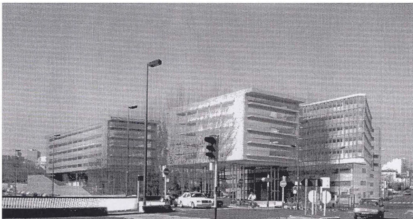
L'architecture en projet : Les studios de Boulogne-Billancourt, Quai du Point du Jour, 1996-99, C. de Portzamparc architecte.
