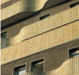
Bruno Rollet - Le Candide - 2012 Vitry-sur-Seine © Bruno Rollet Architecte Garde-corps en osier tissé in situ sur une ossature métallique
