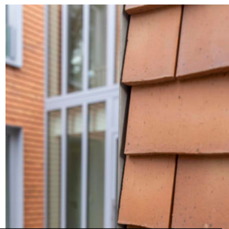
Accusé de réception en préfecture 0922000570442025120862025-09-4-AI Date de télétransmission : 16/12/2025 Date de réception préfecture : 16/12/2025 ©Victor Grandgeorge Tuiles de terre cuite
