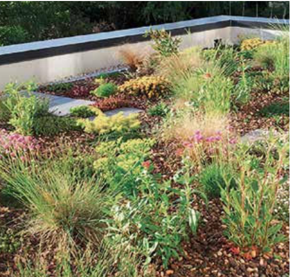
Toiture terrasse végétalisée
