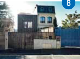
Villas du coteau Nord
