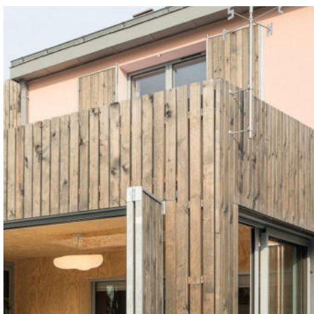
Vendredi architecture, "Chez Claude" Rezé (44), 2017 © François Dantart Structure bois Douglas Revêtement extérieur et volets : bois épicéa commun pré-grisé
