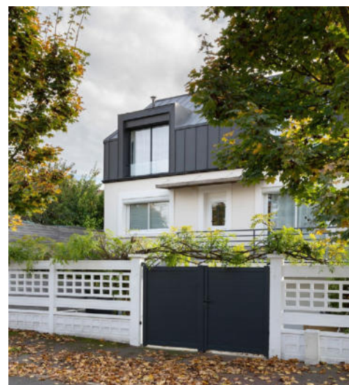
Atelier des Orteaux, maison neuve, Joinville-le-Pont (94) - 2024 © Atelier des Orteaux
