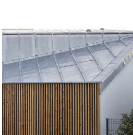
Agnes & Agnes architecture Svères, 2014 © Onze04 Toiture zinc - Étages bardage mélèze - RDC enduit minéral gris clair
