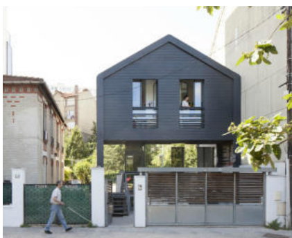
Djuric, Tardio, architectes.
