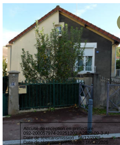
23-25 rue Guynemer Une maison, deux propriétaires
