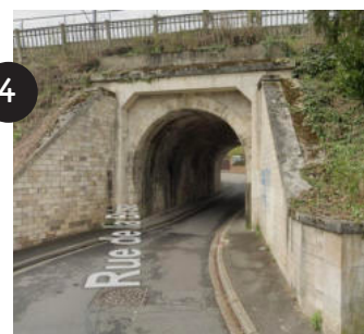
Passage rue de la Brise
