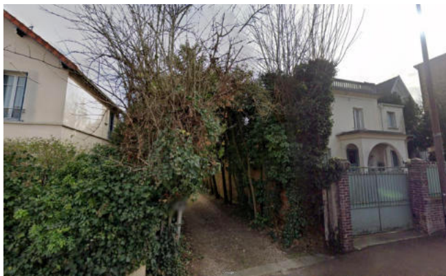
Accès du 57bis, rue de Jouy
