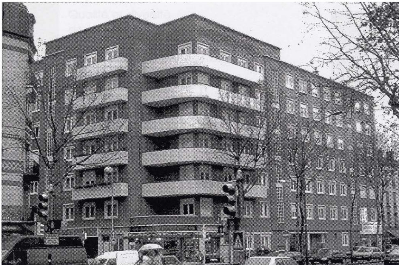
Habitations à Bon Marché, 21, Av. du Gal Leclerc. 1931-34, J. Debat-Ponsan architecte.
