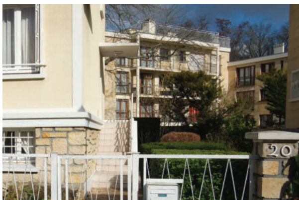
Résidence des Petits-Bois - R+3 en toit-terrasse
