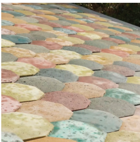
Atelier du ralliement Nantes (44), 2018 © Atelier du ralliement Tuiles de ciment teinté dans la masse (collectifsaga)
