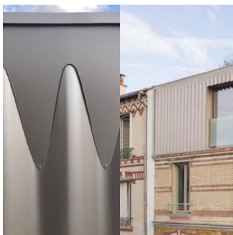
Ellena Mehl architecture Ivry-sur-Seine (94), 2022 © Hervé Ellena Bardage bac métallique
