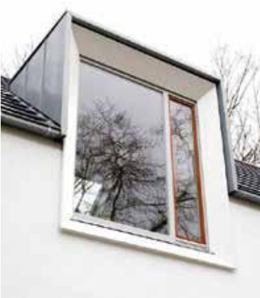
Immeuble d’habitation à Kirchdornberg © DR
