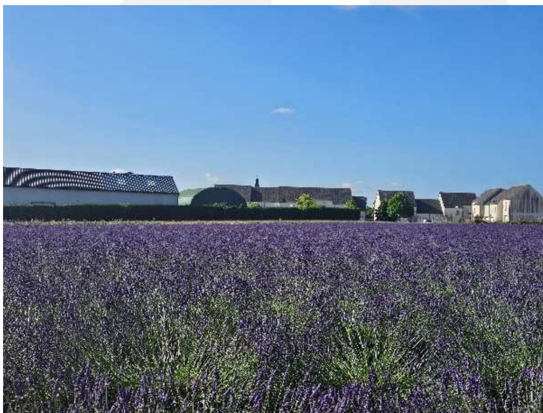
Figure 5 : Vue vers la partie Sud et Sud-Ouest du site
