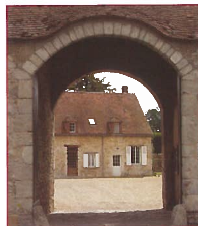
Mur de clôture en maçonnerie de moellons* calcaires hourdés* à la chaux* et chaperon* maçonné à Saint-Léger-des-Aubées.
