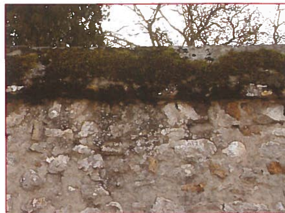
Mur de clôture en maçonnerie de moellons* calcaires hourdés* à la chaux* et chaperon* maçonné à Saint-Léger-des-Aubées.
