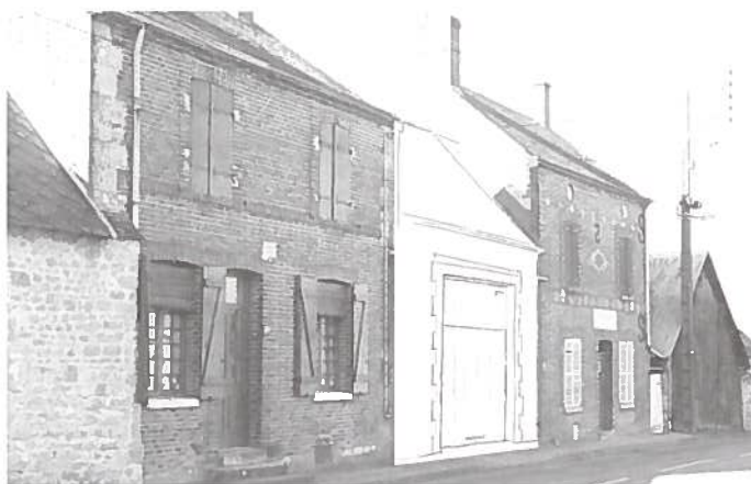
Après : mise en valeur de la baie
