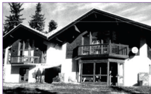
Vue générale du bâtiment
