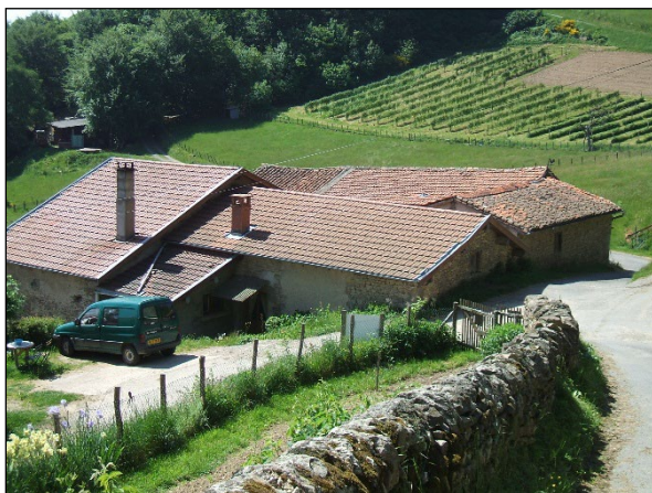
Photographies des bâtiments parcelle K 308
