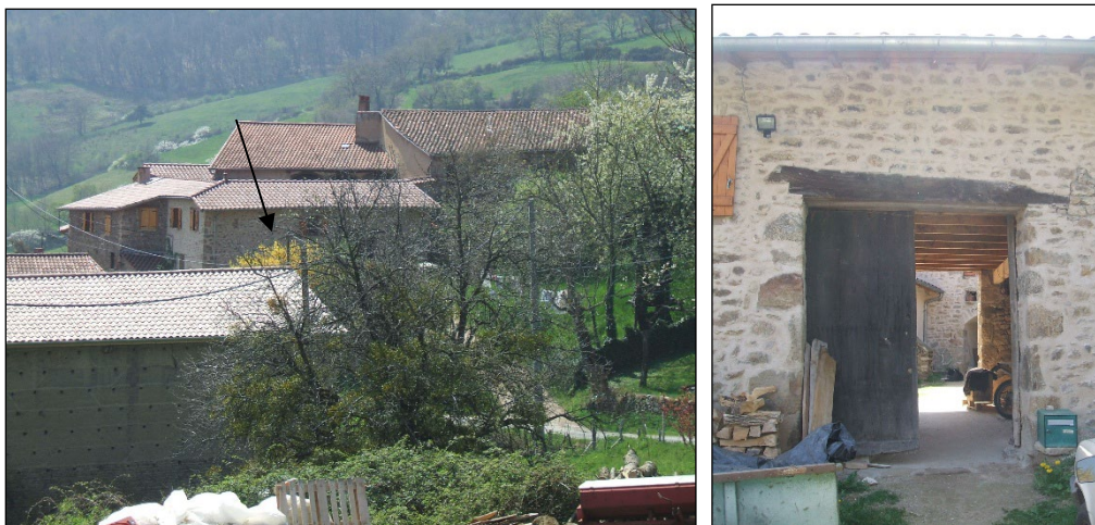
Photographie du bâtiment sis parcelle K 75
