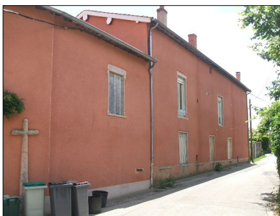
Vue sur la façade est
