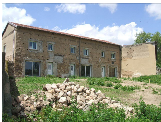
Vue sur la façade est
