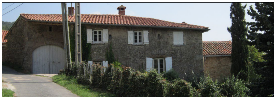
Vue sur la façade ouest du bâtiment
