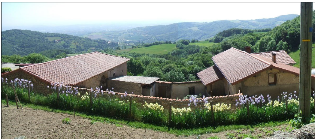
Photographies des bâtiments parcelle K 310
