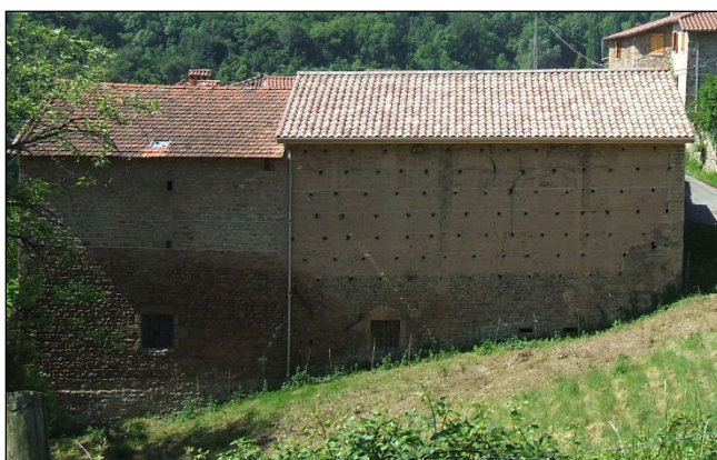
Vue sur le bâtiment (grange)
