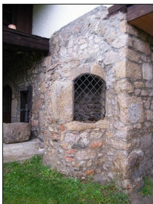
Puits à Maison Blanche
