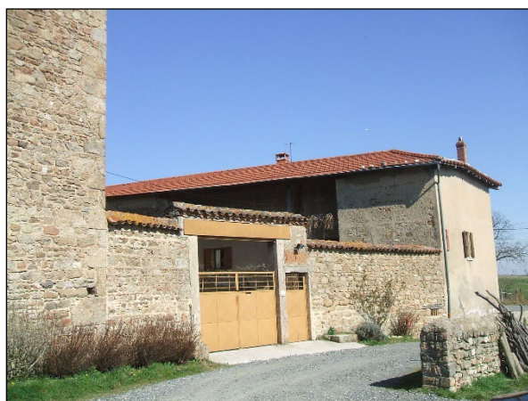
Photographies des bâtiments sur la parcelle B 16
