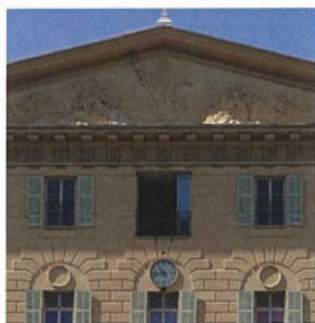
2- Hôpital Saint Roch
