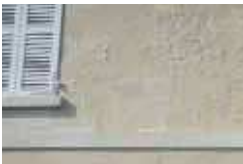
Ravalement d'enduit sur moellon
