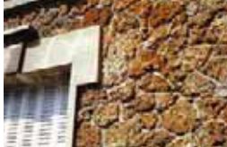
Meulière avec joint creux au mortier bâtard
