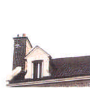
Lucarne maçonnée en bâtière.
