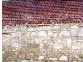
Brique et moellon calcaire
