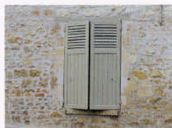
maçonnerie moellon à pierre vue
