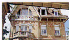
mouvements de toiture : croupes, noues, ornements sur les rives et les faîtages
