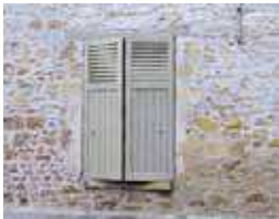
Maçonnerie moellon à pierre vue
