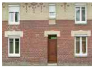
Mur en brique rouge et silico-calcaire
