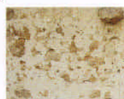
enduit sur moellon
