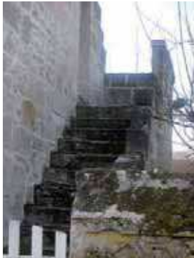
Escalier en pierre sur pignon
