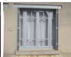
Baie avec linteau et volets métalliques pliants
