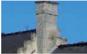
Souche de cheminée en pierre de taille
