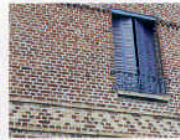
brique rouge, brique silico-calcaire blanche
