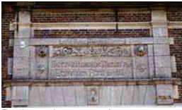
Porche en pierre ouvragée
