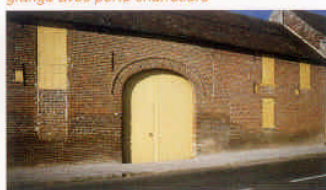
grange avec porte charretière
