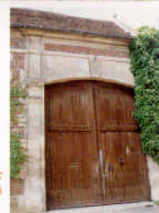
porche d'entrée avec encadrement ouvragé en pierre
