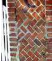
Brique rouge unie, silico-calcaire claire, vernissée et cintrée, badigeonnée en rouge, posée à chevron, formant un escalier ou un couronnement de clôture
