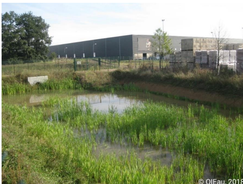
Bassin de rétention végétalisé (eau.seine-et-marne.fr)
