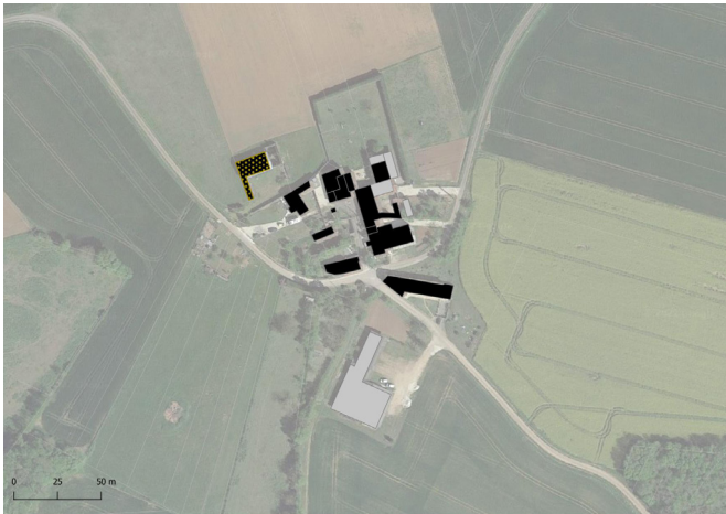
- Bâtiment susceptible de changer de destination au lieu-dit Les Reigner à Chenon -
