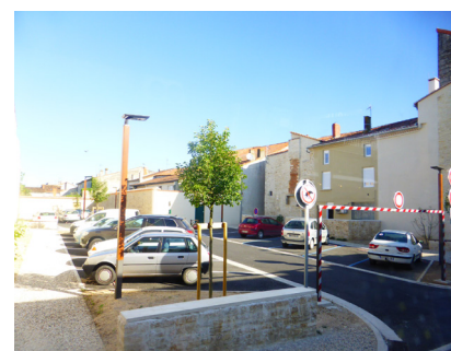
Stationnement aménagé à Mansle
