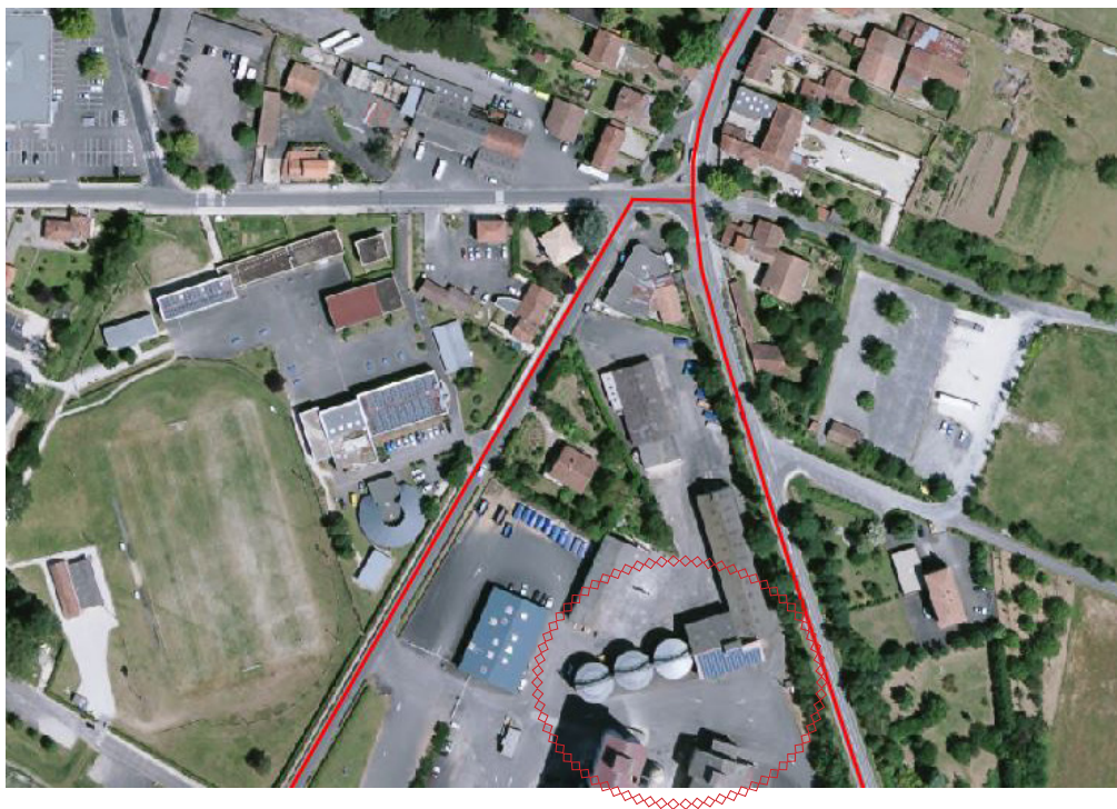
Silos à Mansle
