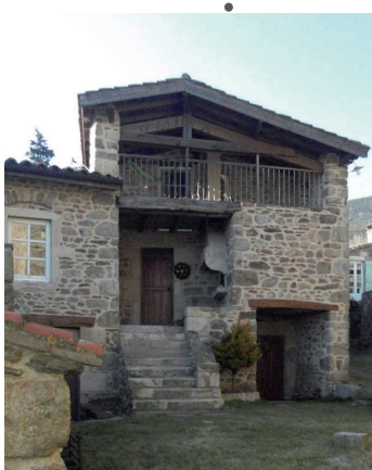
Exemple de débord de toiture
