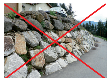
Exemple d'enrochements de type cyclopéen
