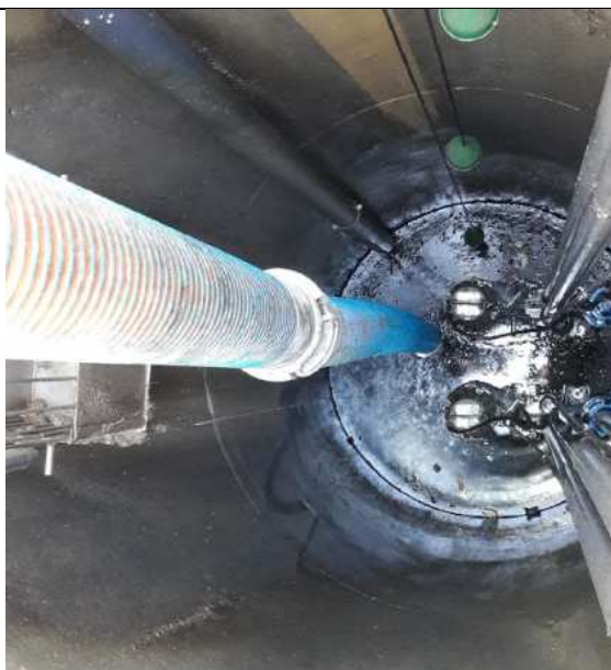
PR N°1 MARDIGNY-Rte de Lorry
