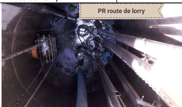
PR LORRY.MARDIGNY-Ruelle aux Chevaux
