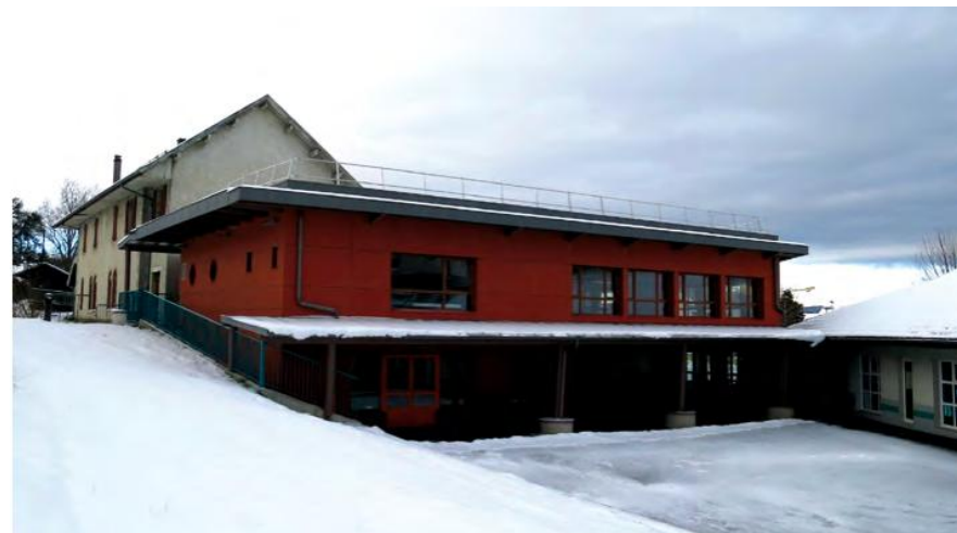
Le bâtiment périscolaire et l'école maternelle
