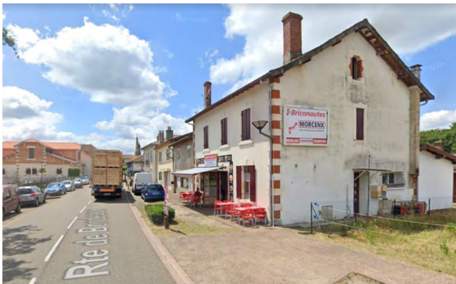
Dispositif mural situé à Sabres, installé sur un mur comportant des ouvertures de plus de 0,50m 2 et en covisibilité avec l'Eglise Saint-Michel (monument historique)
