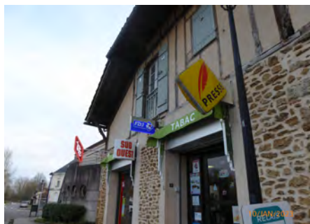
Enseignes perpendiculaires au mur
