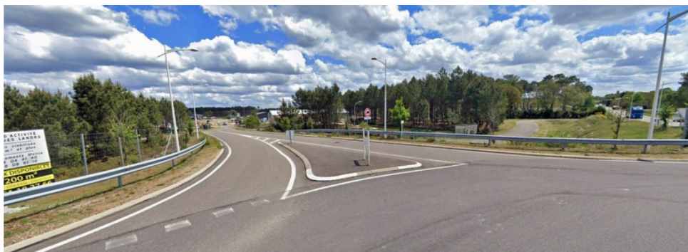
Photo 1 : Entrée sur la ZAE existante depuis le giratoire de l'échangeur d'extension de la ZAE.
