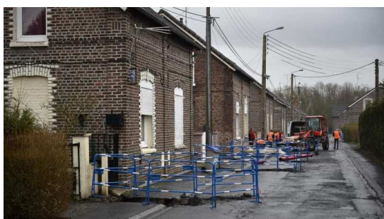
Cité minière Chabaud Latour en phase de rénovation
