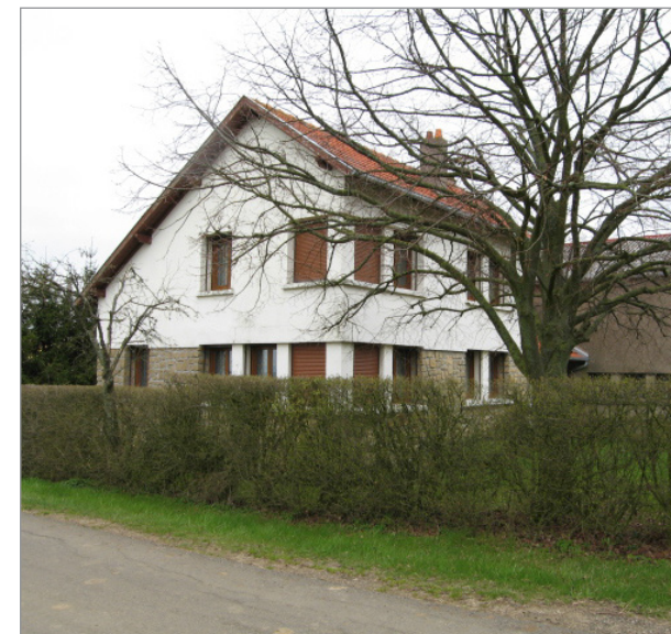
Habitation résolument moderne, entrée est de Goin
