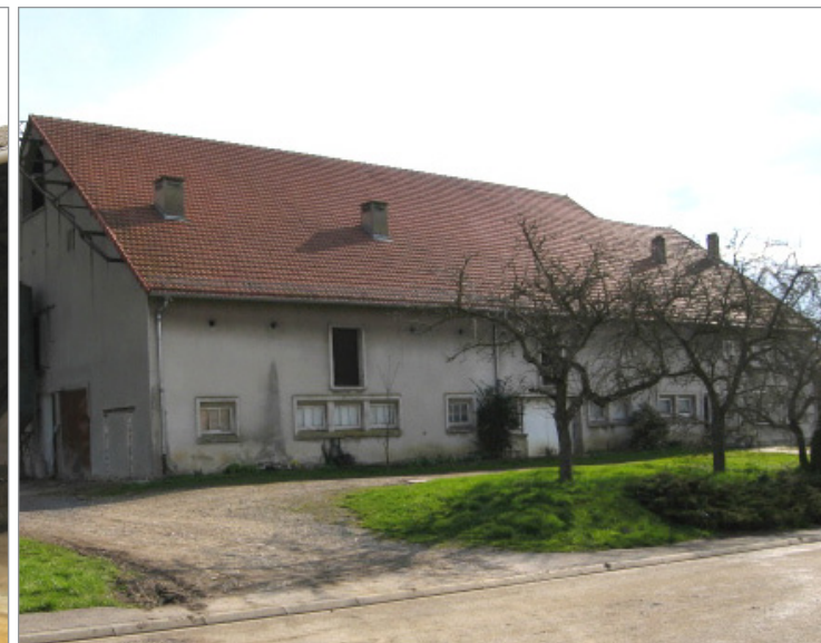
Parties habitation et étable d'une ferme, rue des Fermes à Goin
