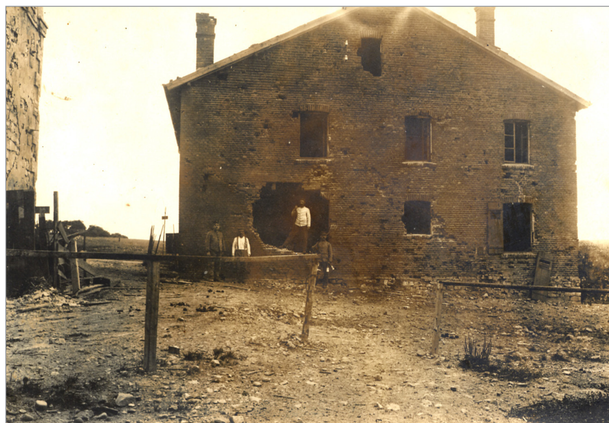
Le four à chaux de Vigny
