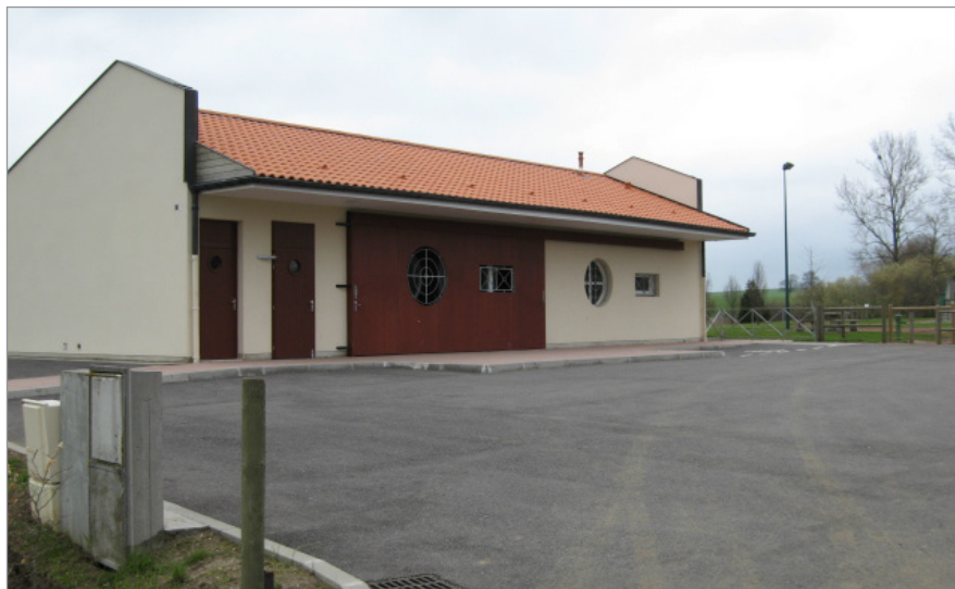
Club House de Goin : une architecture audacieuse qui marque les équipements publics
