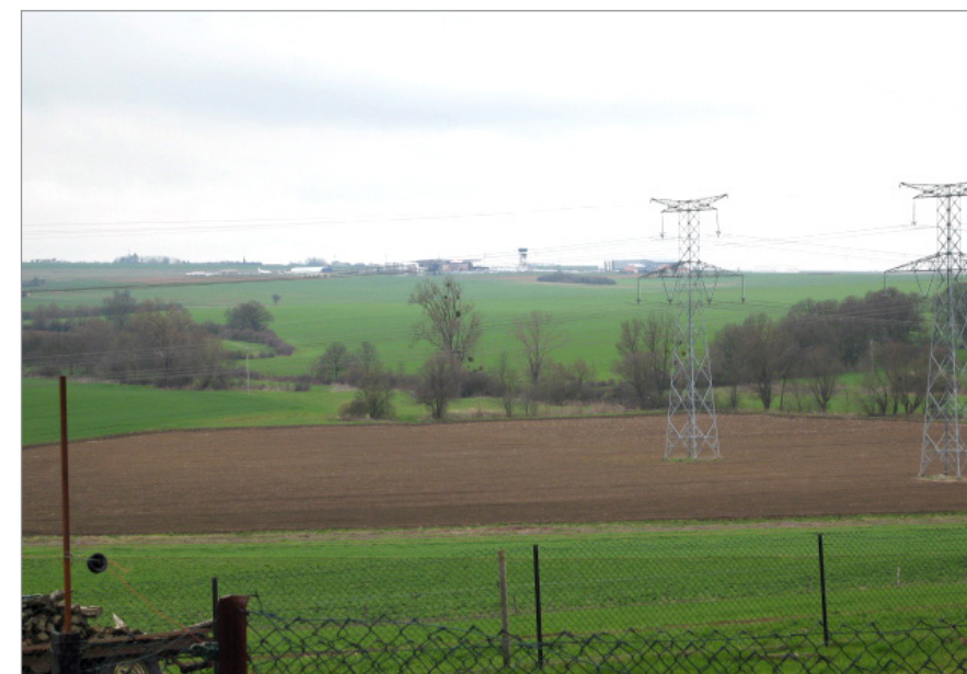
La ligne THT et, à l'horizon, la tour de contrôle de l'aéroport sur la crête
