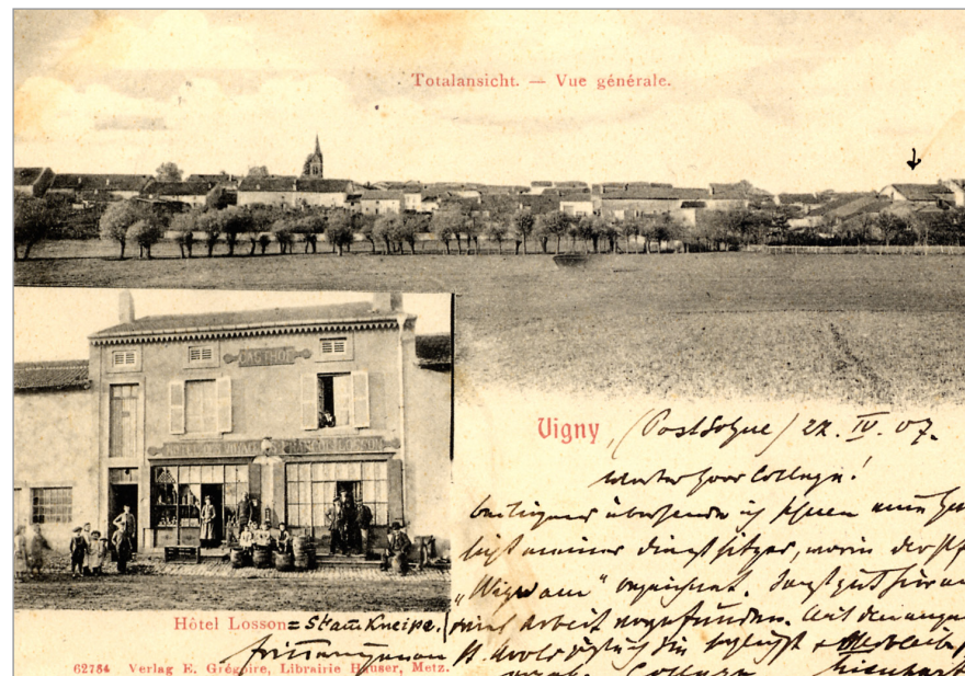
Hôtel Losson et vue du village de Vigny depuis les vergers
