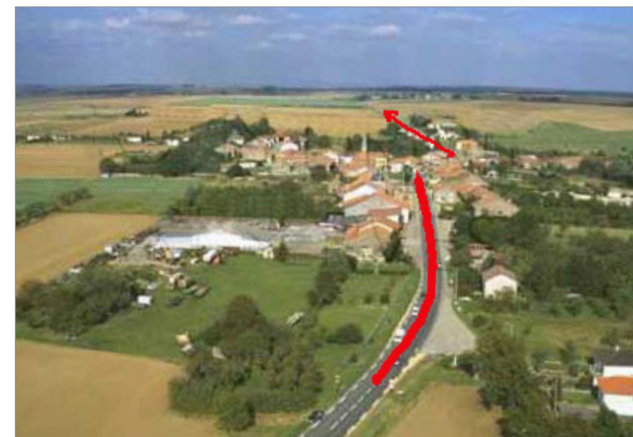
Le goulot d'étranglement de la R.D.910 à Vigny
