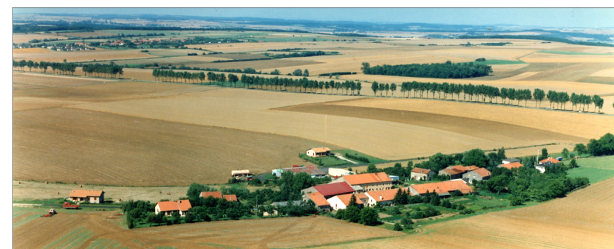
La ligne droite de la R.D.955 à Silly-en-Saulnois, avant l'abattage des arbres d'alignement
