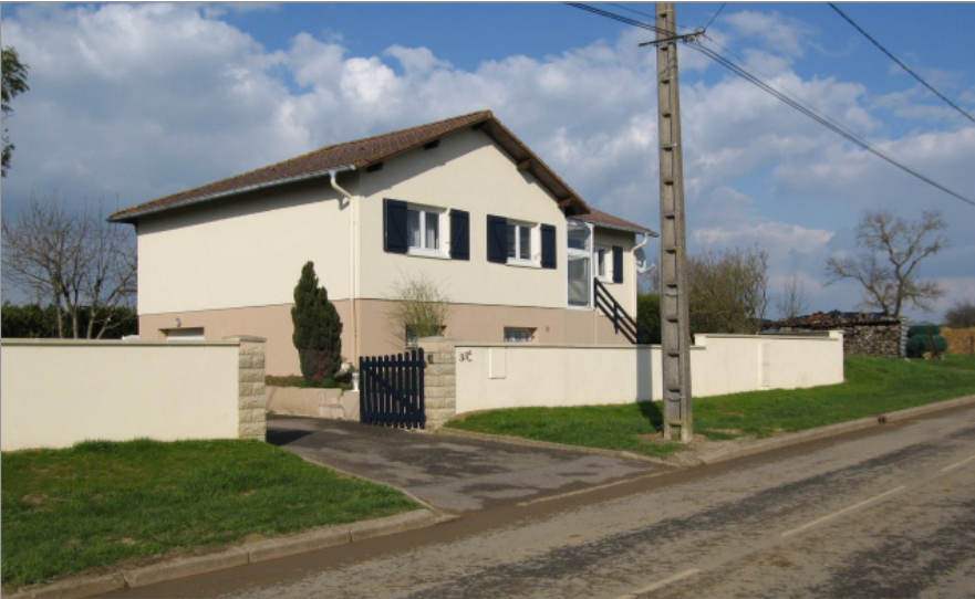
Pavillon des années 1970, rue Principale à Goin
