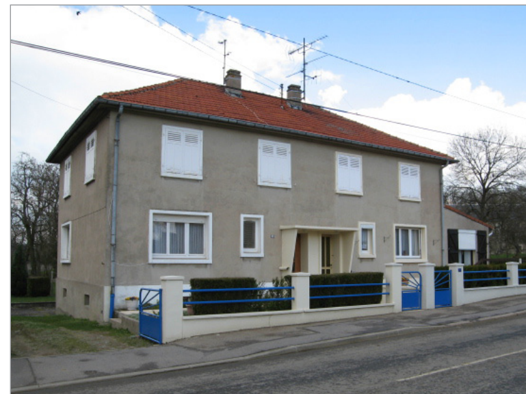
Maisons jumelées, rue Principale à Goin
