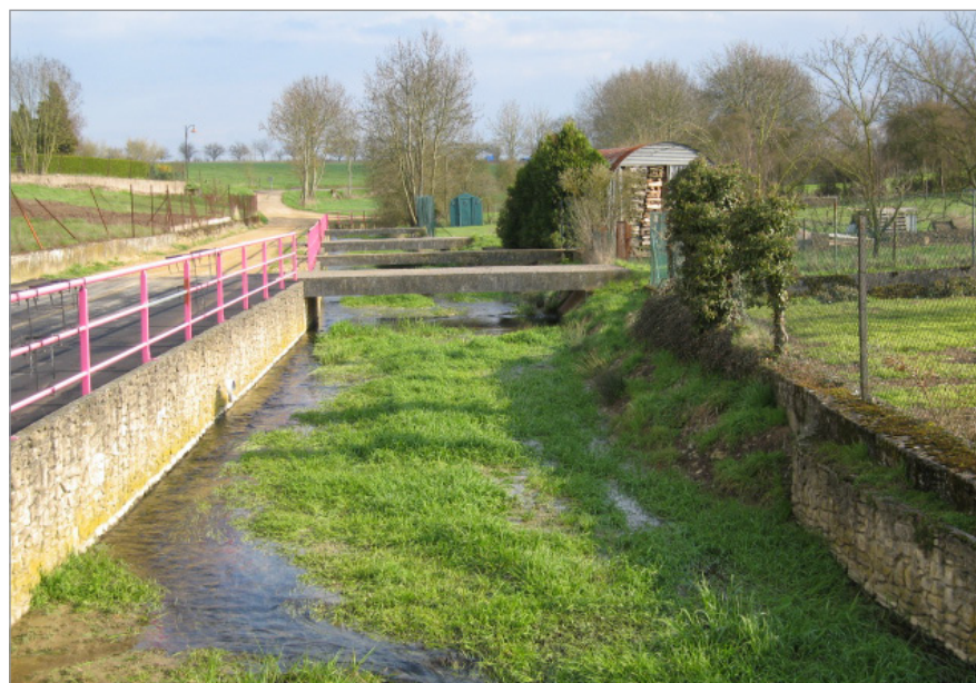
Le ruisseau de Goin canalisé
