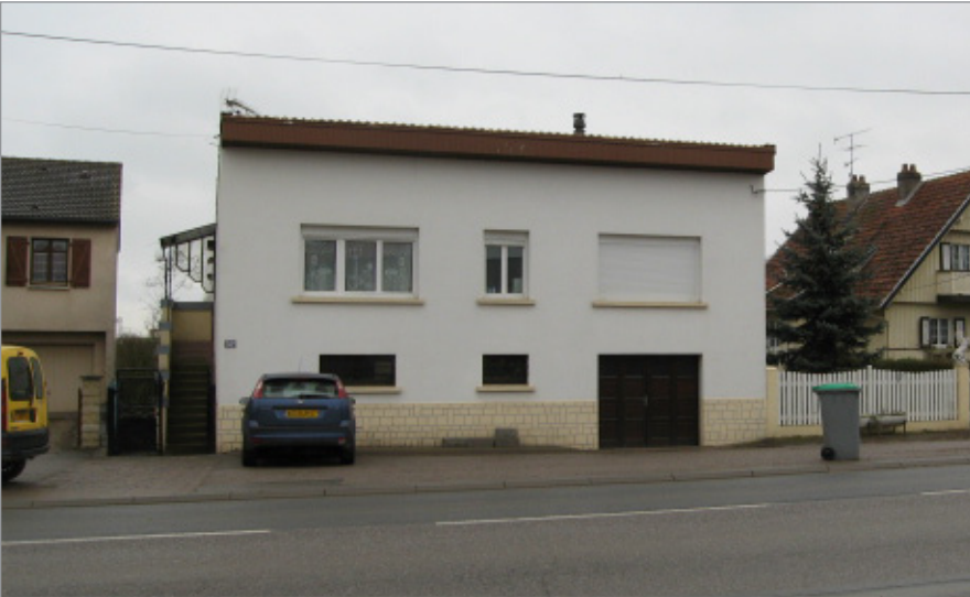
Rue Principale à Vigny
