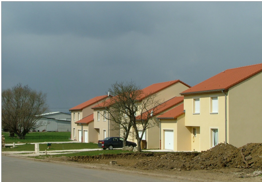
Les nouvelles constructions en ordre semi continu à l'entrée du village
