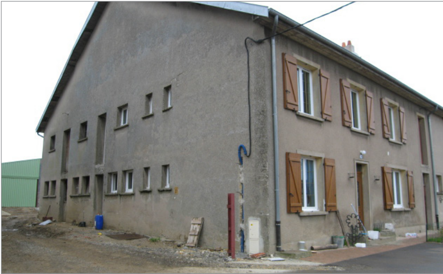
Rue Principale à Vigny
