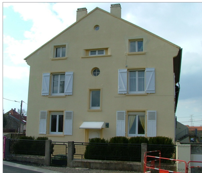
Partie habitation d'une ferme de la Grande Rue à Goin
