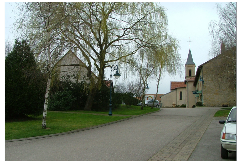
Le clocher pointe entre une végétation abondante et le bâti ancien
