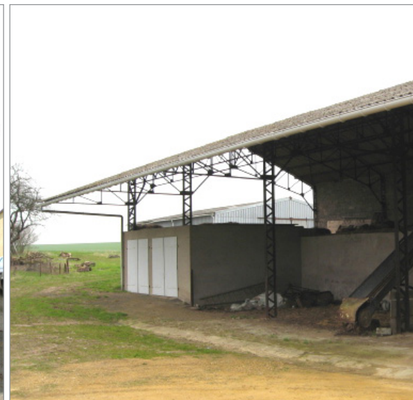
Une structure métallique très fine pour ce hangar de Vigny
