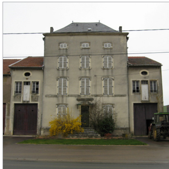
Maison de maître à l'abandon, rue Principale à Vigny
