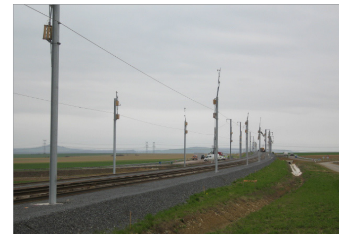
La LGV aux confins sud de Vigny et de Pagny PLU de la C.C.A.A.R.L.
