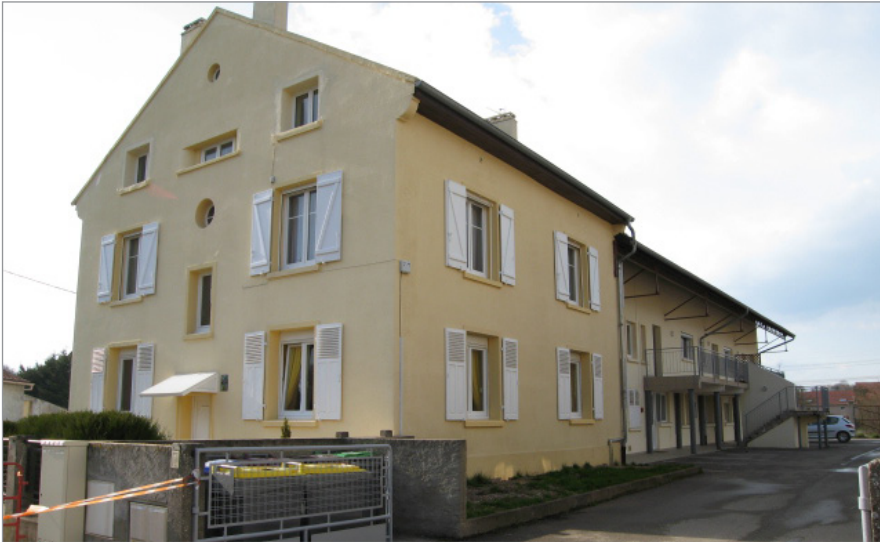
Grande Rue à Goin : ferme transformée en logements collectifs
