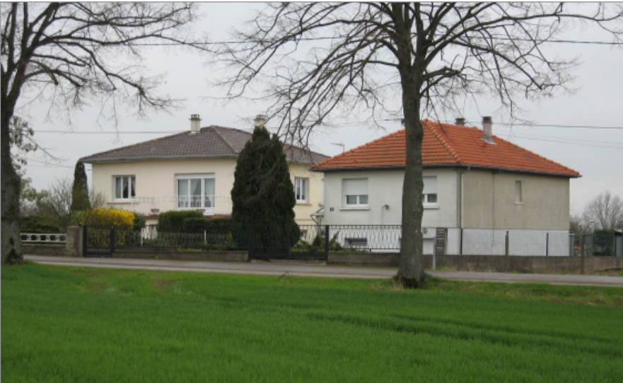
Pavillons des années 1960-70 à Vigny
