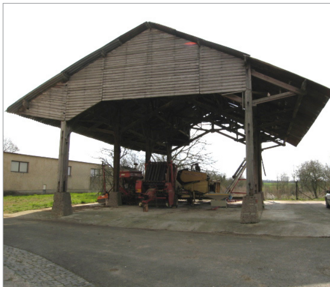
Hangar à structure bois, impasse du Quegnot à Pagny-lès-Goin
