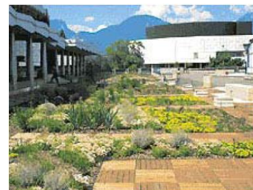
Terrasse végétalisée – Système semi-intensif Grenoble – Crédit agricole
