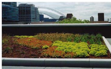
Toiture végétalisée Système extensif (type garrigue)
