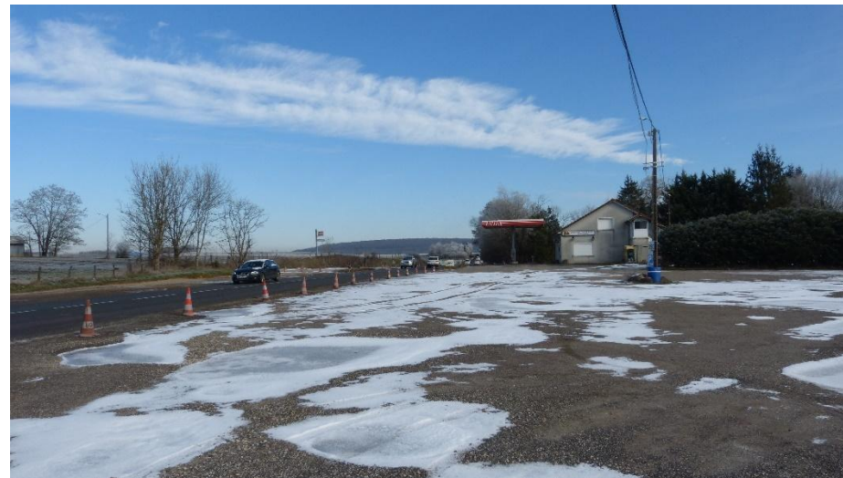
Station-service et restaurant à Velleminfroy (source : IAD)
