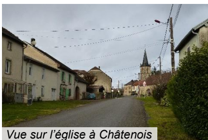
Vue sur l'église à Châtenois
