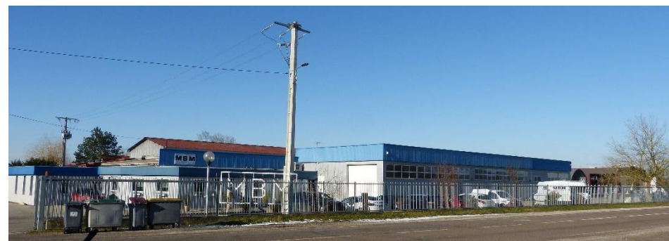
Bâtiment MBM (source : IAD)
