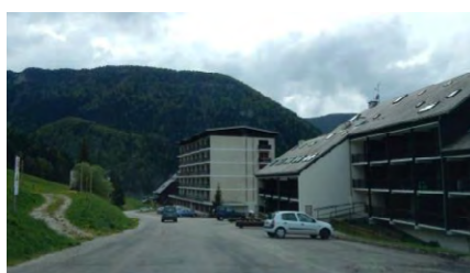
Parkings des résidences touristiques, Aillon-Station
