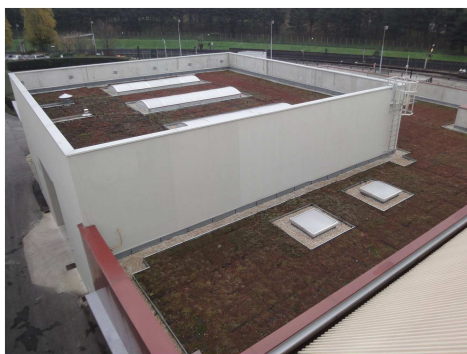
Toiture terrasse stockante
