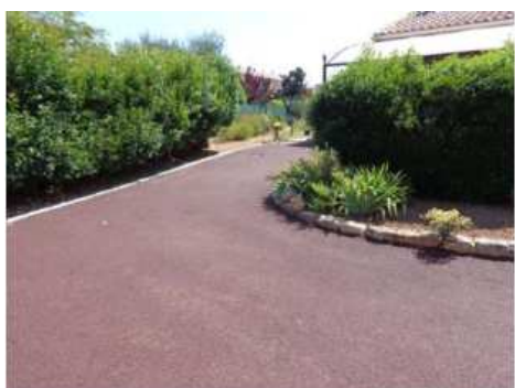
Allée/parking en enrobé poreux (source : Celtivia)
