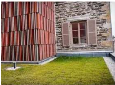
Toiture végétalisée (source : Grand Lyon)
