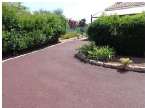
Allée/parking en enrobé poreux (source : Celtivia)
