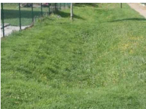
Noue en bordure d'allée (source : Alise Environnement)
