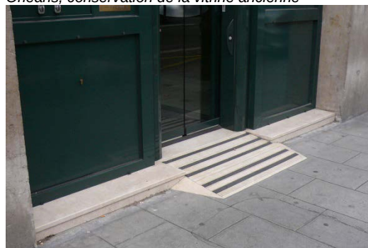
Mise en accessibilité, Grenoble
