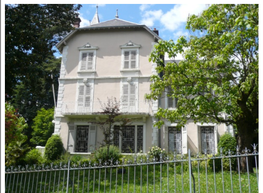
Exemple Terrain protégé au clos Savoiroux
