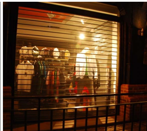
Les rideaux à maille fines ou très perforés sont préférables aux rideaux pleins, dans le but de garder une certaine transparence quand le commerce est fermé.
