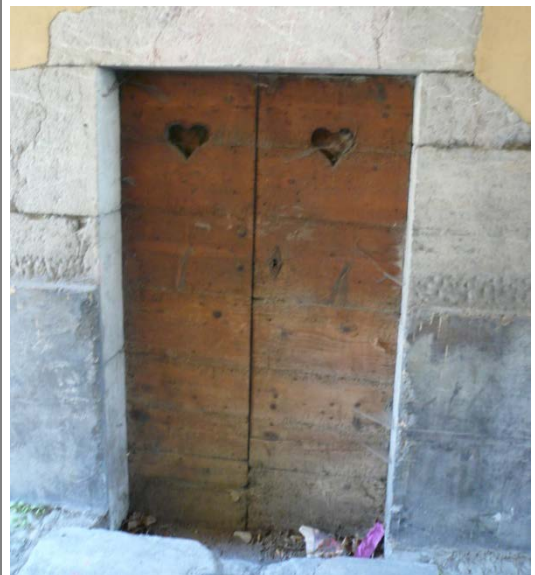
Porte à conserver, place Monge
