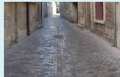
Pavés rejointoyés avec caniveau central
