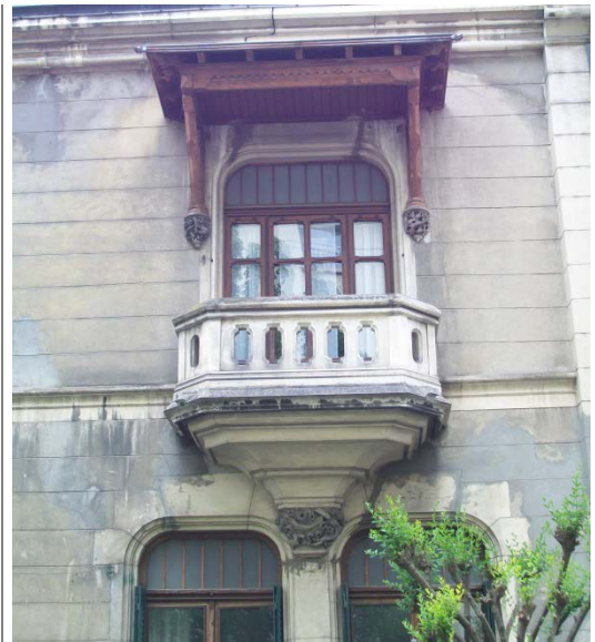
Rue Marcoz, menuiseries anciennes à conserver
