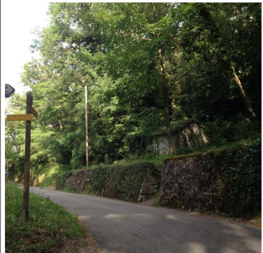
Mur protégé, les Charmettes
