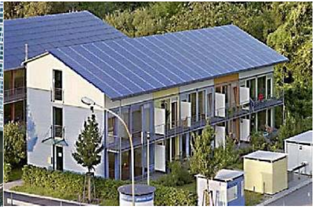
Panneaux photovoltaïques sur la totalité d'un versant
