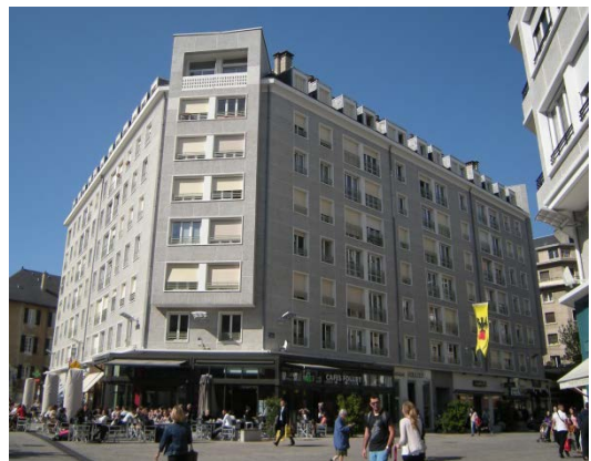
Immeuble en béton rue Saint Antoine
