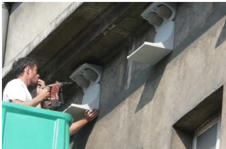
Nichoirs de substitution proposés aux hirondelles, avec planchettes anti-fientes afin d'éviter les nuisances. Caserne de Bonne, Grenoble
