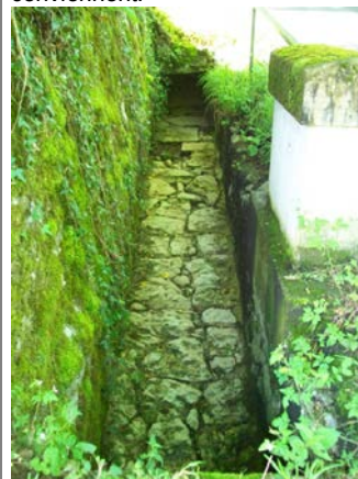
Rigole en pierres, à préserver et à valoriser Les Charmettes.
