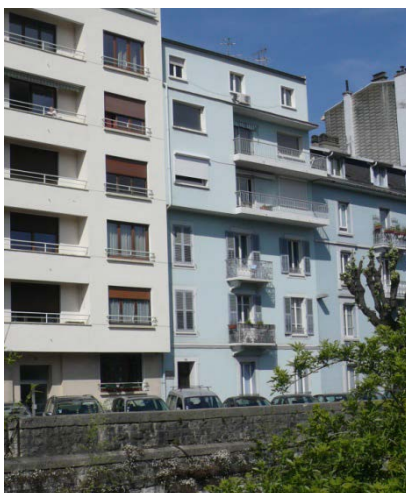
Quai Charles Ravet, immeuble de gauche
