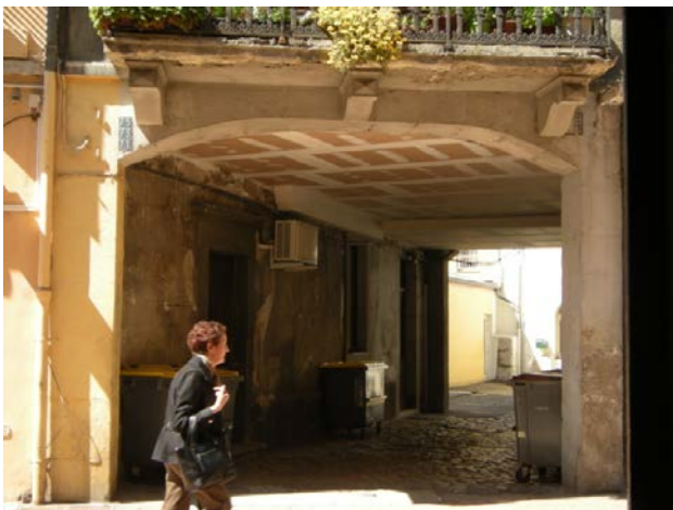
Exemples d'isolation par le dessous dans un passage ; à éviter ! (perte du volume et du décor peint)
