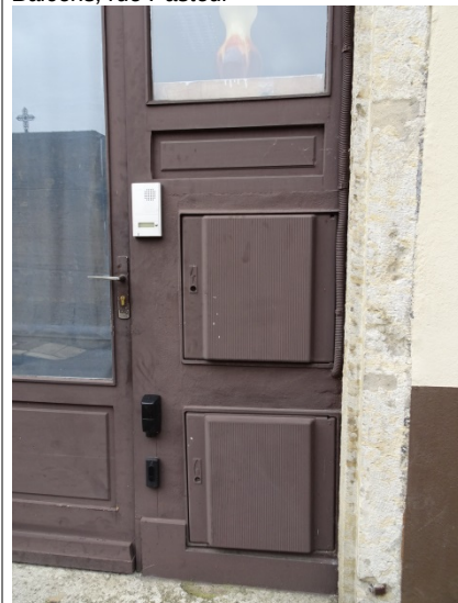
Autre solution de dissimulation des compteurs, (encastrés dans la menuiserie et peints) Vienne
