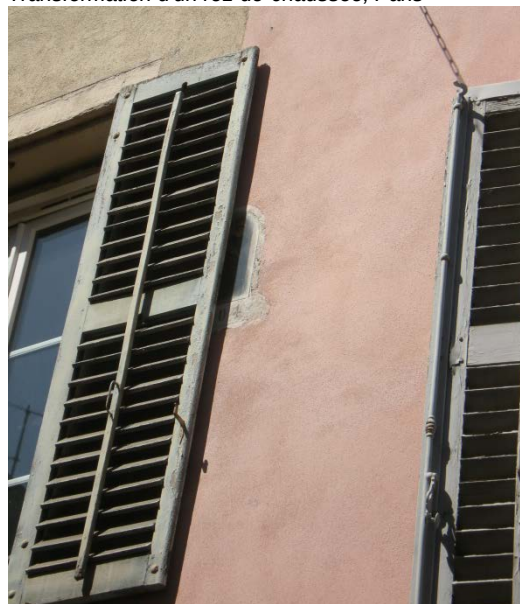
Exemple de contrevents anciens que l'on trouve fréquemment à Chambéry. Un mécanisme permet d'actionner l'orientation des persiennes.
