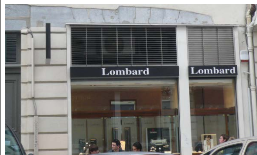
Climatiseurs intégrés dans les vitrines, Grenoble
