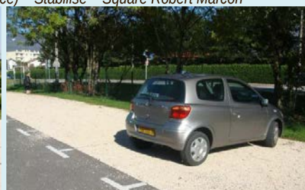
Parking en stabilisé (Sassenage, Isère)
