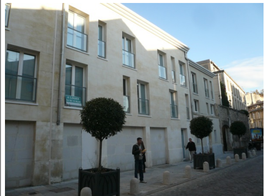
Avignon, immeuble neuf, façade en pierres agrafées, mur ventilé
