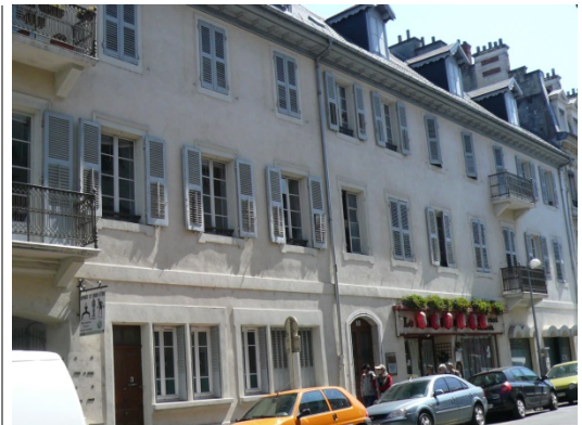
Rue de la Banque, unité des ouvertures
