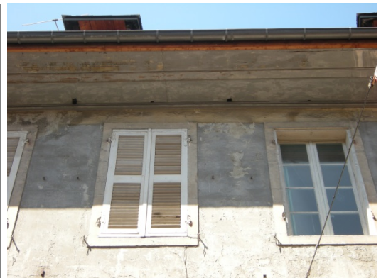
Passée de toit caissonnée
