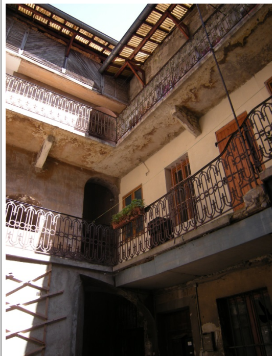
Balcons rue d'Italie. Le balcon inférieur a été dénaturé par un socle en béton.
