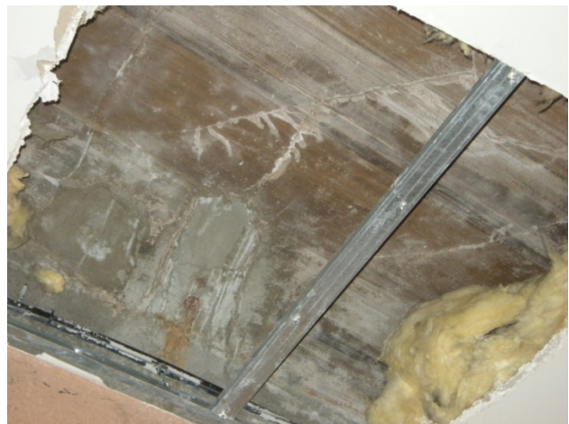
Exemples d'isolation par le dessous dans un passage ; à éviter ! (perte du volume et du décor peint)
