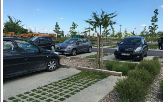
Exemples Aménagements aires de stationnement végétalisées
