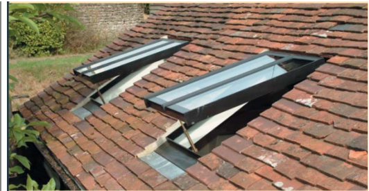
Les fenêtres de toit « patrimoine » sont mieux adaptées aux toitures anciennes
