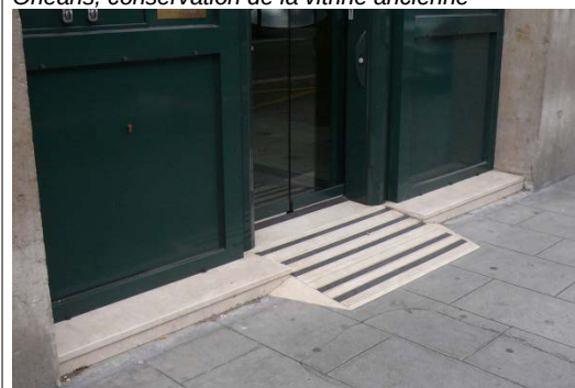
Mise en accessibilité, Grenoble
