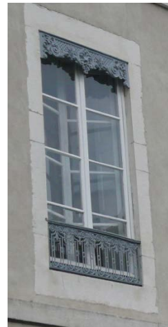
Double fenêtre à Grenoble correctement intégrée
