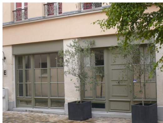
Transformation d'un rez-de-chaussée, Paris
