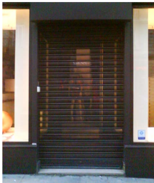
Les rideaux à maille fines ou très perforés sont préférables aux rideaux pleins, dans le but de garder une certaine transparence quand le commerce est fermé.
