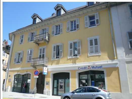
Place d'Italie, murs en pierres de blocage enduits
