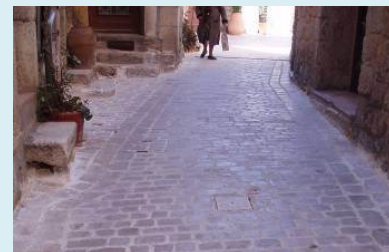
Pavés rejointoyés au mortier de chaux avec bandeaux latéraux
