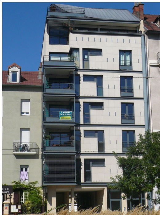
Grenoble, toiture à versants
