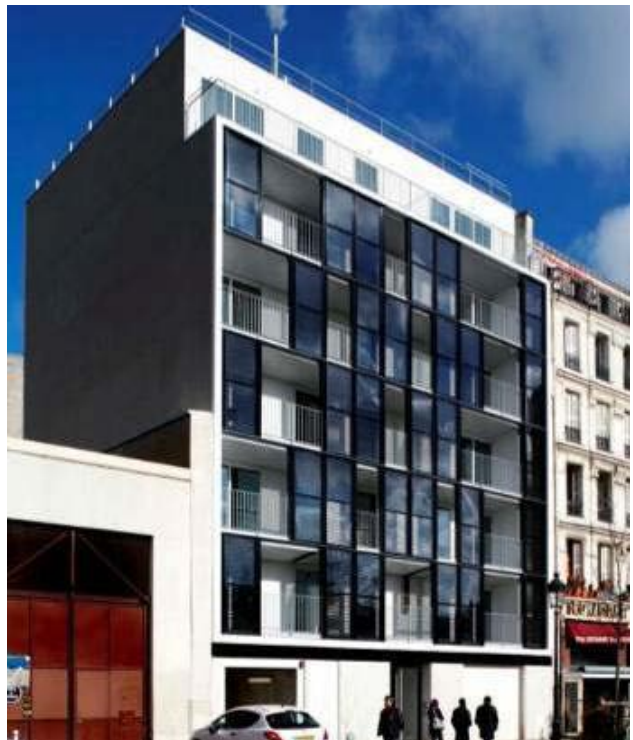
Agence Philippo- Kalt : immeuble de logements, Paris, avec vitrage isolant +capteur thermique (ECS) en façade
