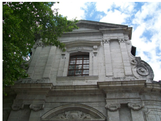
Chapelle du Lycée, pierres appareillées
