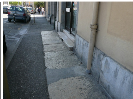
Seuils en pierre, avenue de Lyon
