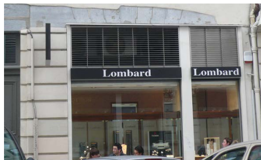
Climatiseurs intégrés dans les vitrines, Grenoble
