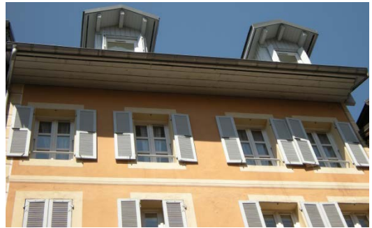
Faubourg Montmélian, immeuble à faible ornementation
