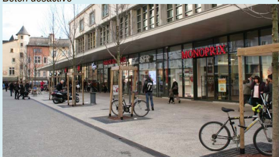
Béton désactivé – Les Halles (Chambéry)
