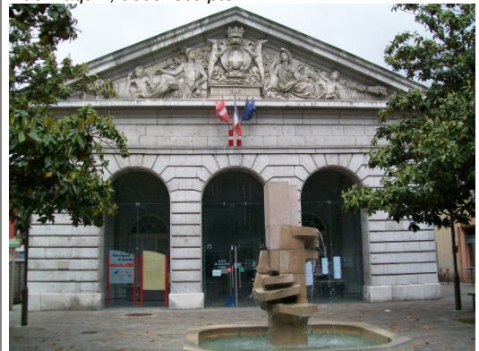
Place de la Grenette, pierres appareillées
