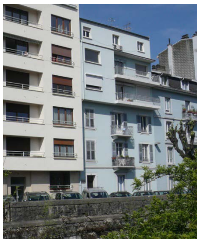
Quai Charles Ravet, immeuble de gauche
