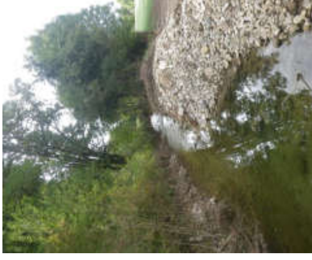
Berge emportée et vîgnes arrachées. Intervention d'urgence de création d'un meîlon temporaire avec des matériaux déposés.
