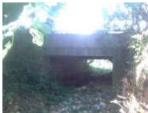
Aval de l'ouvrage CPR03
