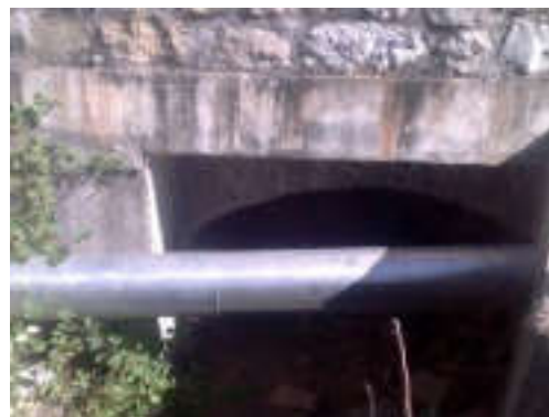
Aval de l'ouvrage ANT07 – Ruissseau de Brame
