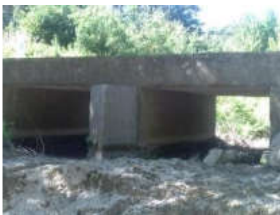
Aval de l'ouvrage _OU02
