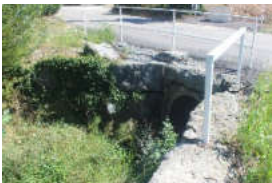
Aval de l'ouvrage FRE07 – Lieu-dit du petit-Bois
