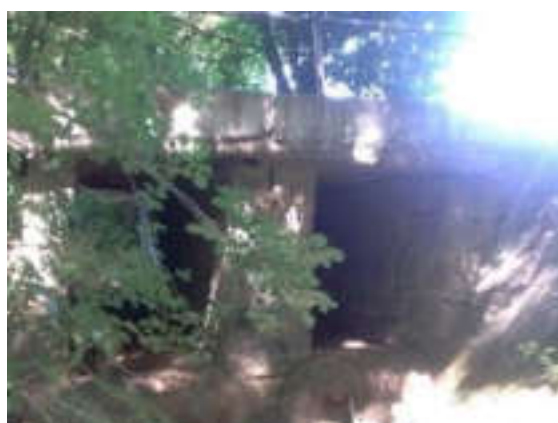
Aval de l'ouvrage ANT01
