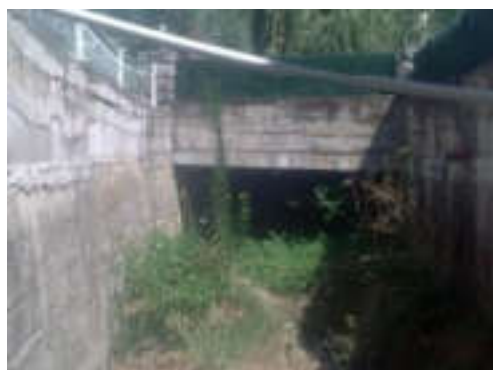
Aval de l'ouvrage FRF04
