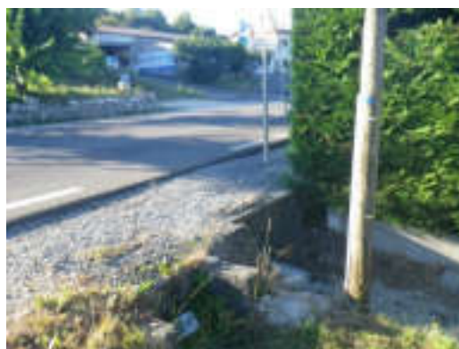
Ouvrage traversant la RD.579 et captant les ruissellements
