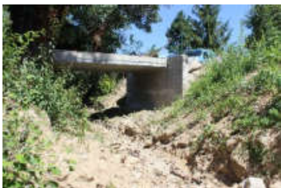
Aval de l'ouvrage FRE01
