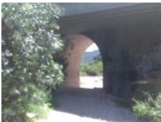
Amont de l'ouvrage _OU01
