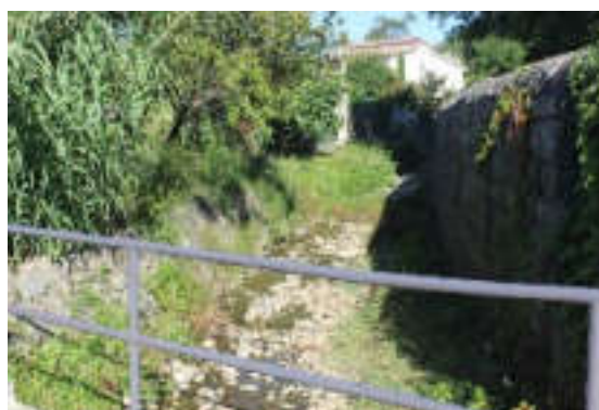
Vue du lit mineur du ruisseau des Antalos depuis ANT02 – Mur en rive gauche
