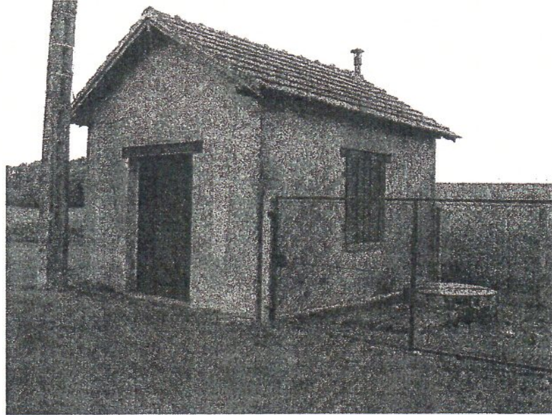
Photo 5 : forage au sein du périmètre clôturé, avec portail d'accès et local technique (commandes électriques) – parcelle cadastrale enherbée et non totalement close
