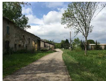
Bâtiments agricoles en ruine, hameau de Schell
