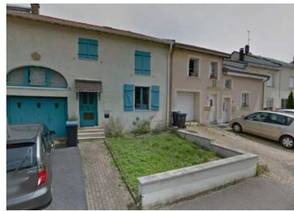
Rue Principale, usoirs utilisés comme stationnement
