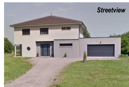
Pavillon récent, Vinsberg
