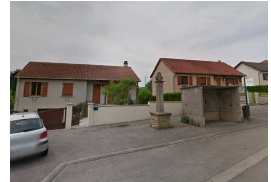
Maison individuelle de type RDC avec toit à 2 pans, lotissement les Vignes Reinange
