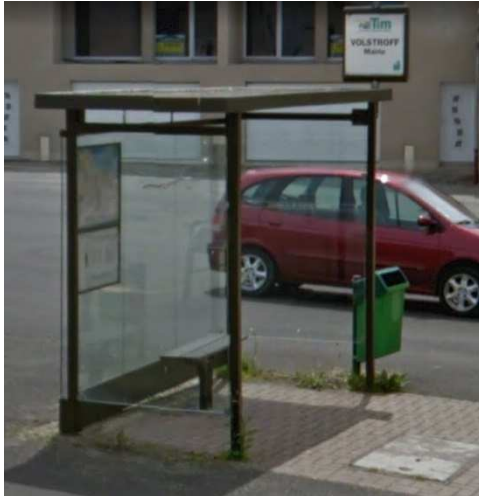
Abribus rue Principale, Volstroff
