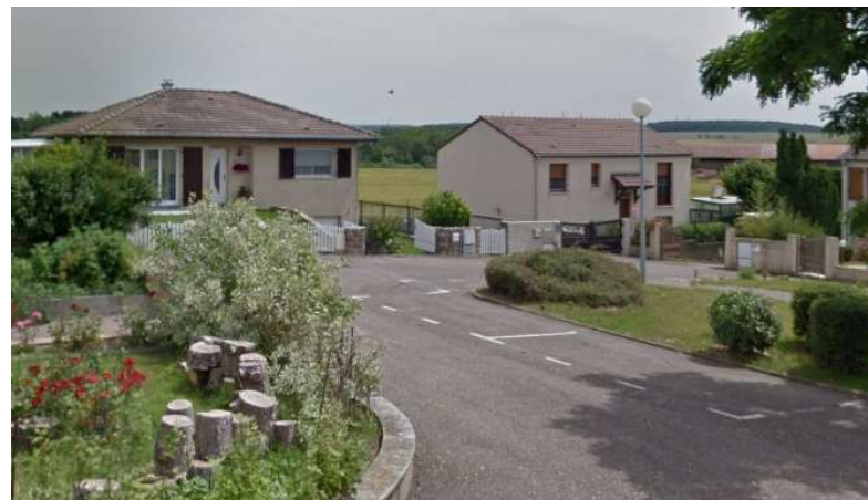
Stationnement linéaire rue des Bleuets à Volstroff
