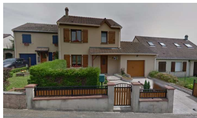
Maison en bande de type RDC et R+1, lotissement la Fleur des Champs Volstroff
