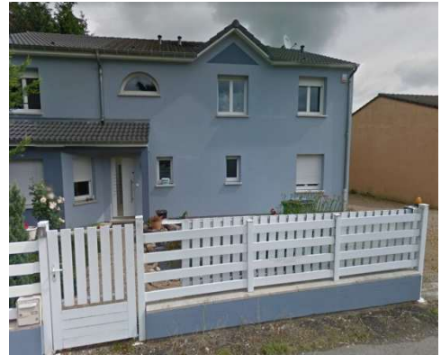
Clôture à claire-voie
