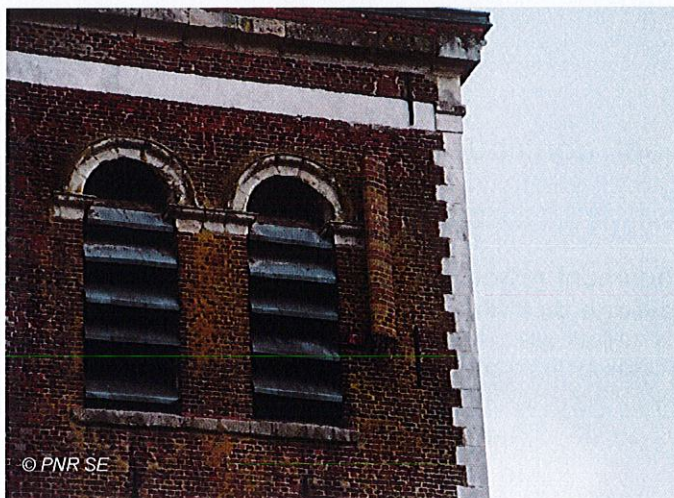
Exemple d'une antenne relais intégrée (église de Fenain)
