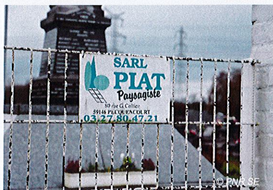
Clôture du cimetière
