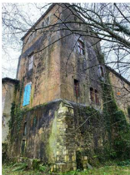
Etat initial façade Ouest
