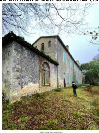
Etat initial façade Nord
