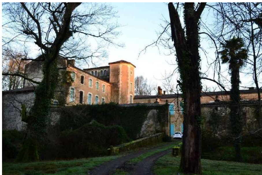
Château des Evêques © ETEN Environnement, Juillet 2021
