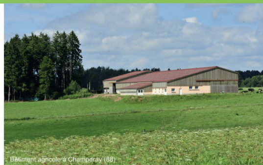
Bâtiment agricole à Chamodray (88)
